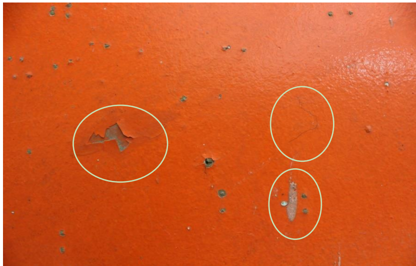
Figura 68: Lacuna com destacamento e reintegração cromática; sujidades superficiais (pelo e escorrimentos).
