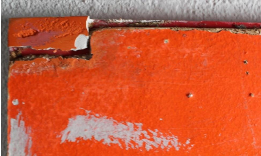
Figura 61: Preenchimento de uma lacuna volumétrica.
