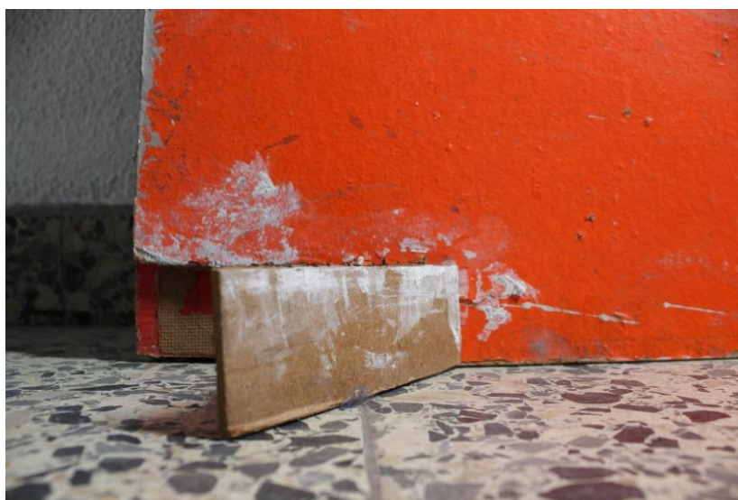
Figura 63: Preenchimento volumétrico do suporte.
