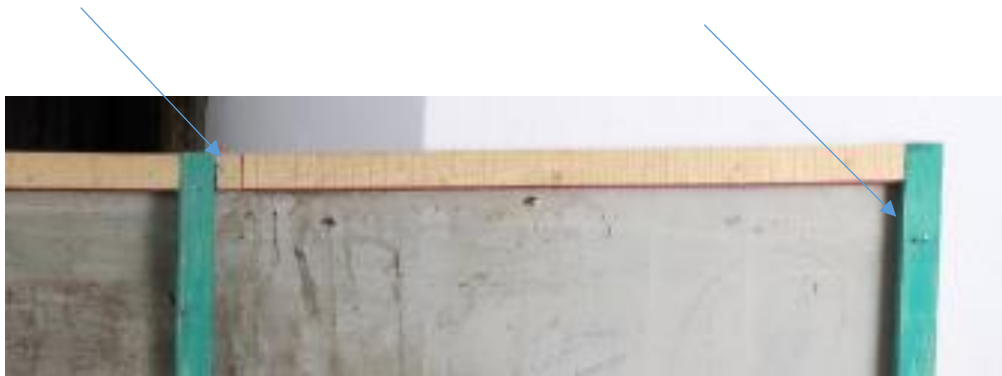
Figura 60: Detalhe onde é possível observar um remendo da grade (à esquerda) e um dos pregos (à direita).
