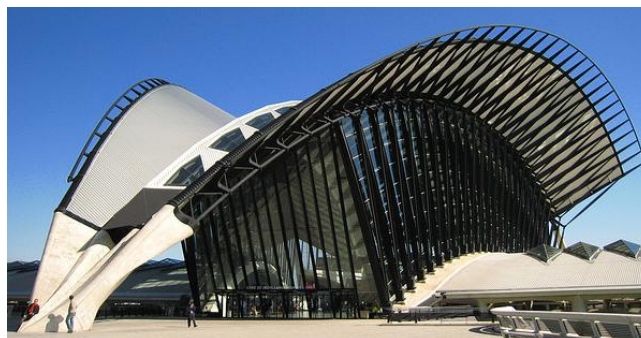
Figura 16 – Terminal de TGV de Satolas-Lyon, Santiago Calatrava
