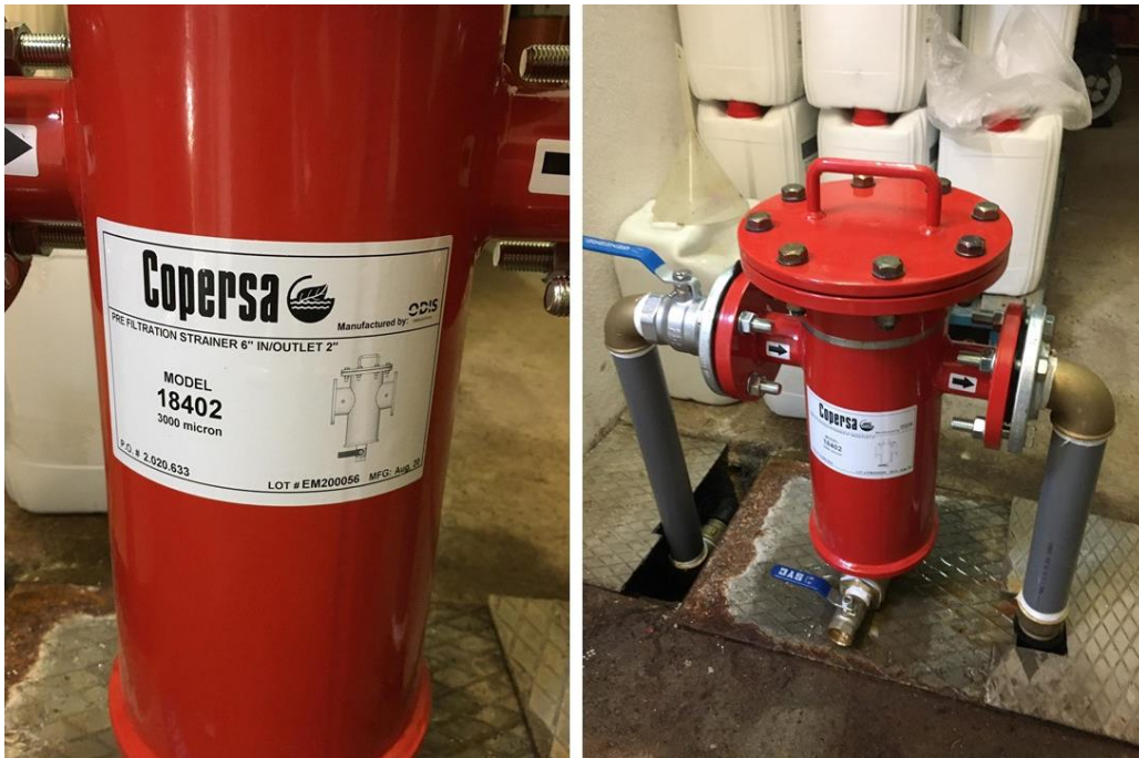
Figura 6: Filtro de malha de 3 mm série 18400 (Copersa, Espanha).
