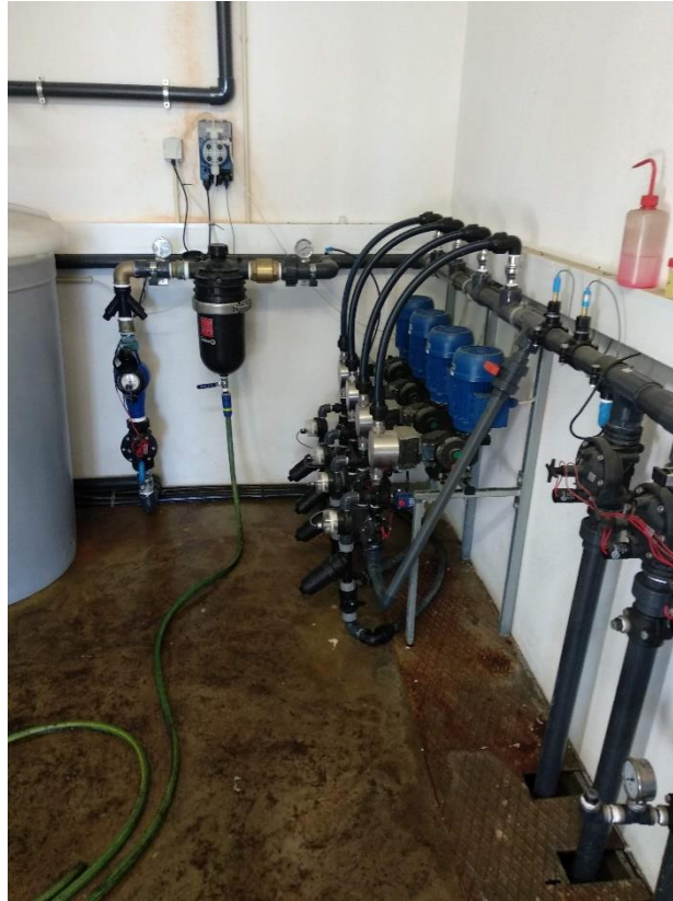
Figura 2: Configuração do cabeçal de rega.
