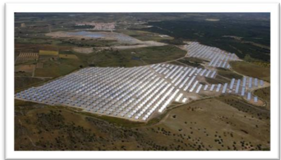
Figura 3.8 – Central Fotovoltaica da Amareleja, Portugal (apea.com)
