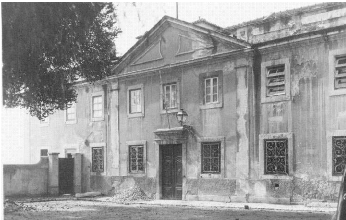
Figura 1: Edifício de S. João Nepomuneceno (onde ficou instalado o primeiro liceu de Lisboa e do país).
