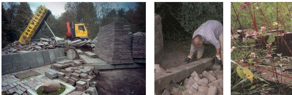
Figura 99 | Construção do projecto
