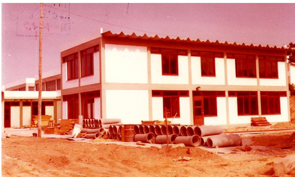
Figura 20. Vista do exterior, última fase da construção da Escola da Quarteira. 1976. Núcleo de arquivo técnico de construções escolares. Ministério de Educação de Portugal.
