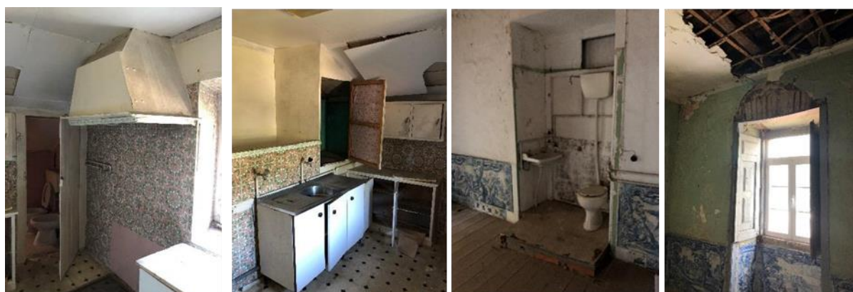
Figura 6: Registo fotográfico do estado atual do interior da Casa D. Miguel. Fonte: Câmara de Oeiras
