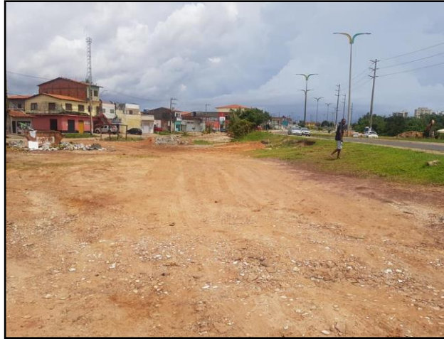
Figura 102 - Local da intervenção urbanística antes das obras
