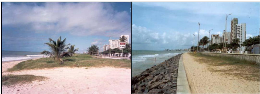
Figura 84 - Aspectos do trecho especificado na década de 80, antes do projeto e do processo erosivo e trecho após erosão e intervenção pela prefeitura
