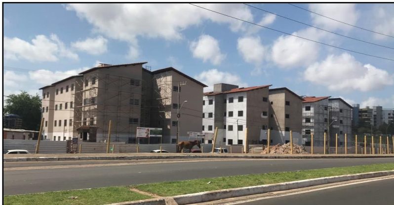
Figura 100 - Andamento da obra do Res. José Chagas na Ilhinha
