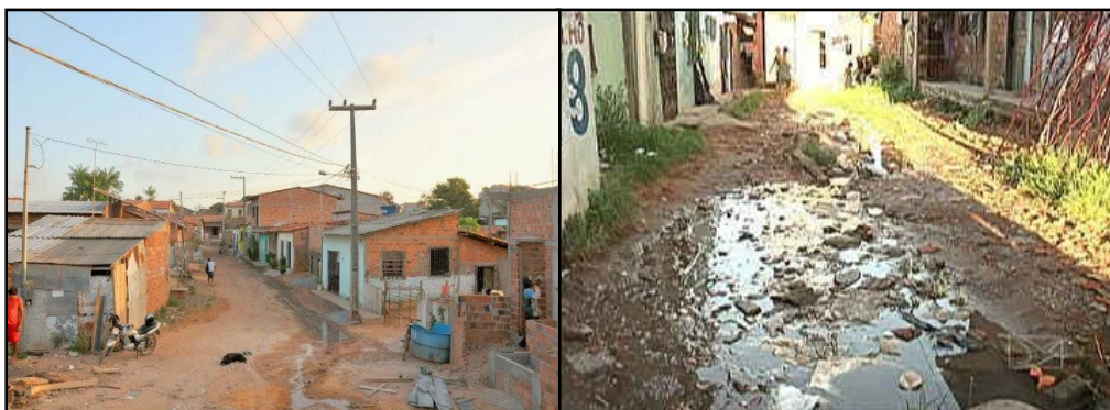
Figura 4 - Falta de infraestrutura na área
