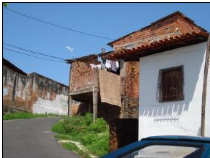
Figura 59 - Desnível em um dos acessos ao bairro
