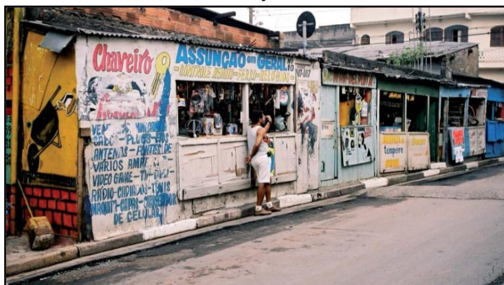
Figura 73 - Rua Ernest Renan, instalações comerciais invadindo a calçada
