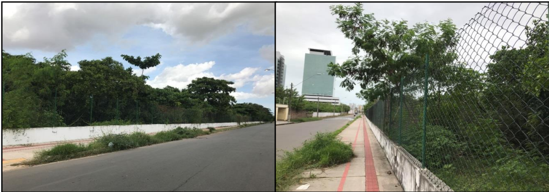
Figura 17 - Proteção em forma de alambrado como barreira entre a Península e Ilhinha
