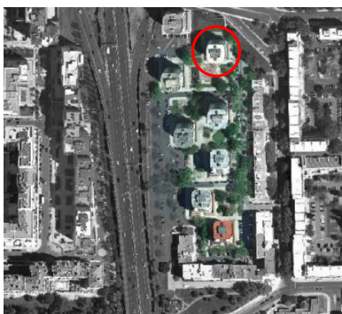
Figura 52 - Vista aérea do edifício 2 (2016)
