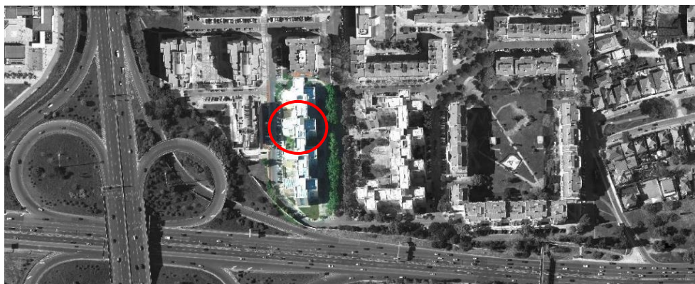
Figura 28 - Vista área do edifício 1 (2016)
