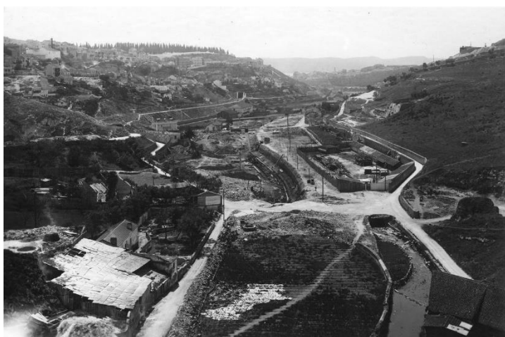
33. Obras de canalização da ribeira de Alcântara e construção da Avenida de Ceuta.
