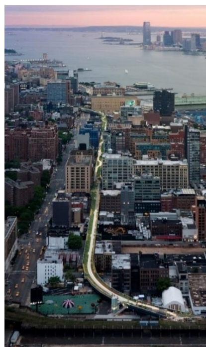
19. Fotografia do High Line Relação do espaço público e áreas verdes com o edificado envolvente.
