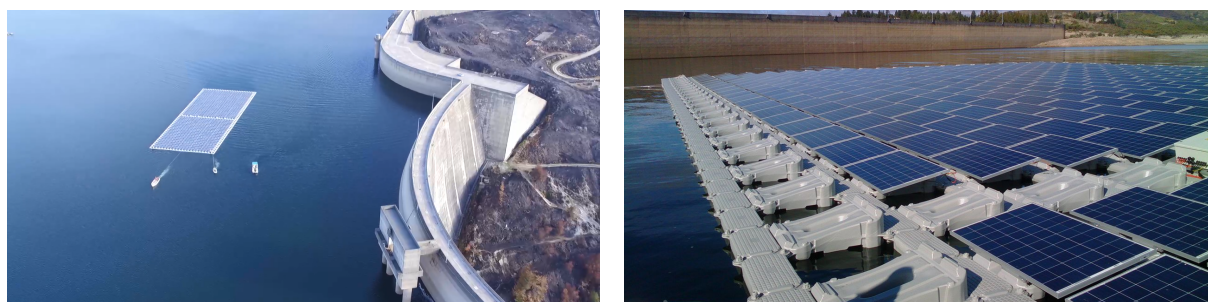
Figura 2.7: Instalação piloto da central flutuante no AH do Alto Rabagão.
