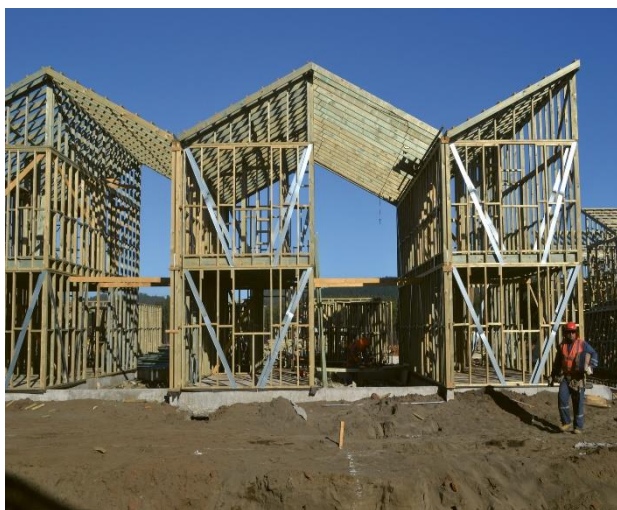
Figura |36 Estruturas das habitações Villa Verde (Chile 2010)
