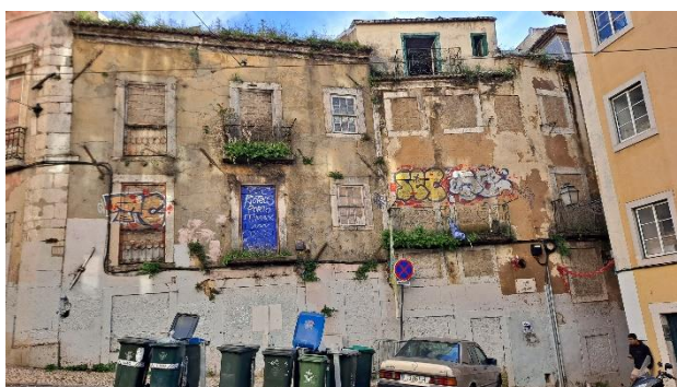
Figura |47 Edifício habitacional devoluto, Lisboa, 2024 (autor)
