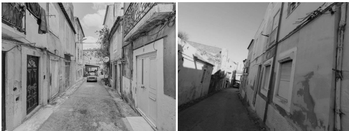
Figura |60 Estruturas arquitetónicas das habitações e ruas tradicionais da zona mais antiga de Setúbal
