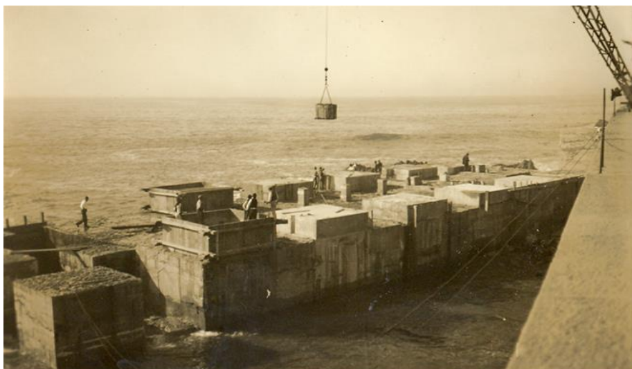
Figura 51. Obras do Molhe no Porto de Leixões, blocos de betão concebidos com cimento «Liz», s. d. AHFML
