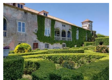
Figura 33 Fachada tardoz - As loggias | Fonte: SIPA
