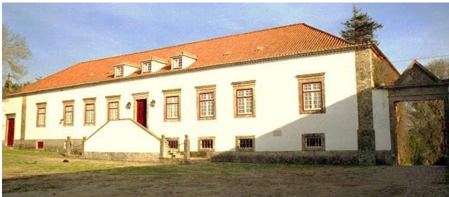
Figura 32 Fachada principal da casa | Fonte: SIPA
