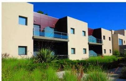
Figura 18 Fachada exterior, zona dos quartos | Fonte: residenciasenior.egasmoniz.edu.pt
