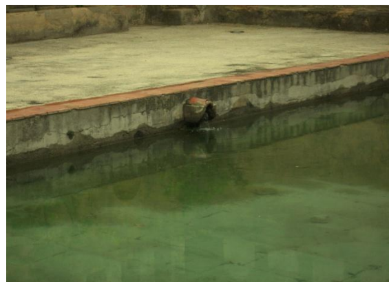
FIG.42 – Pormenor da entrada de água no tanque central (autora)
