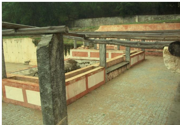
FIG.44 – Estrutura actualmente existente no Jardim de São Gonçalo (autora)
