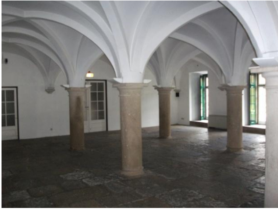
FIG.26 – Sala dos Arcos – aspecto actual (autores)
