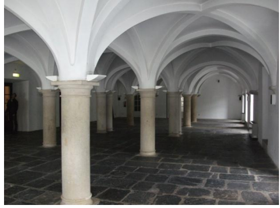
FIG.27 – Sala dos Arcos – aspecto actual (autores)
