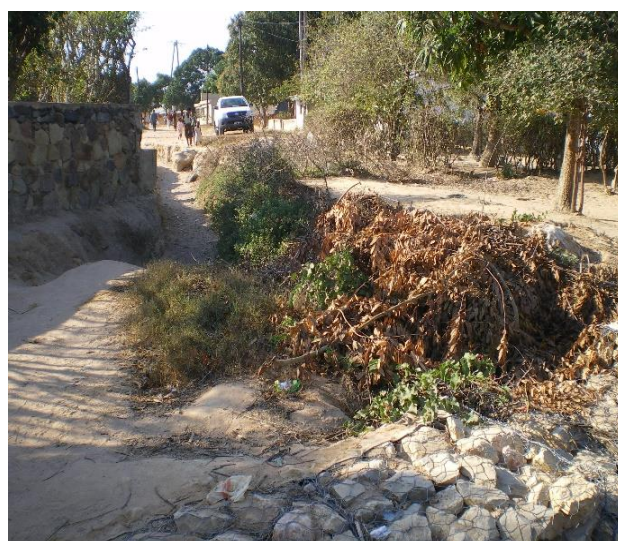
Figura 4.14: Uso de gabiões para contenção da erosão (foto tirada pelo autor 23.02.2016).
