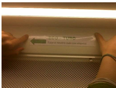
Figura 100 – Colocação de uma etiqueta de indicação da posição correta de instalação de lâmpadas Eco-Tubo®
