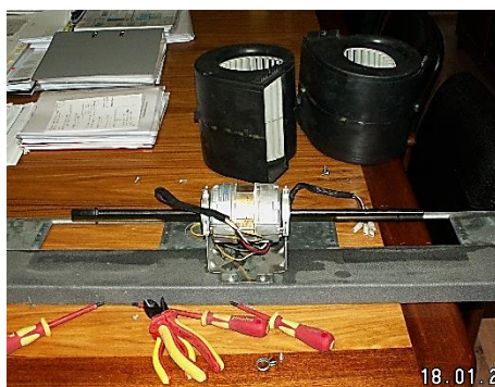
Figura 94 – Desmontagem e reparação do grupo moto-ventilador de um ventilador
