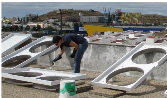
Figura 64 – Pintura das placas de sustentação dos ventiladores
