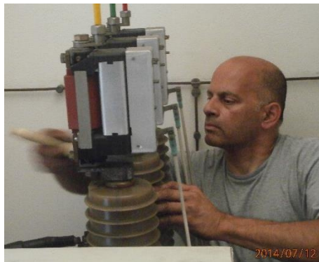
Figura 49 – Limpeza e manutenção dos equipamentos instalados no posto de transformação
