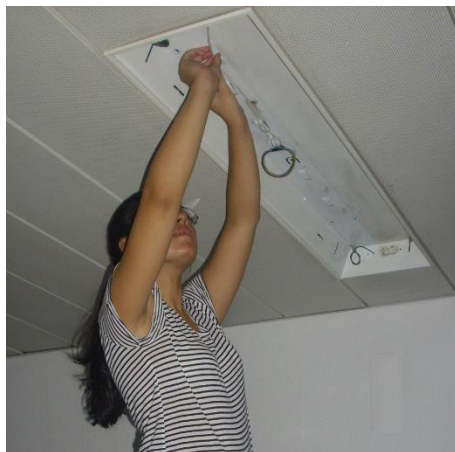
Figura 98 – Modificação da instalação elétrica das luminárias para instalação das lâmpadas Eco-Tubo®
