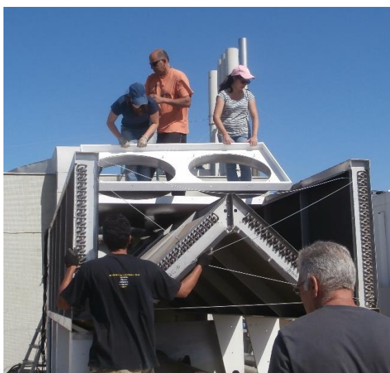
Figura 65 – Colocação das placas de sustentação dos ventiladores
