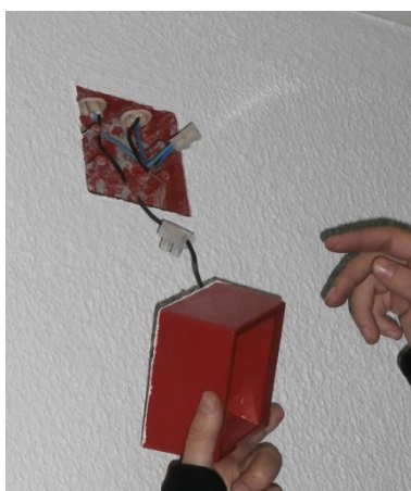
Figura 123 – Remoção das sirenes de alarme sonoro
