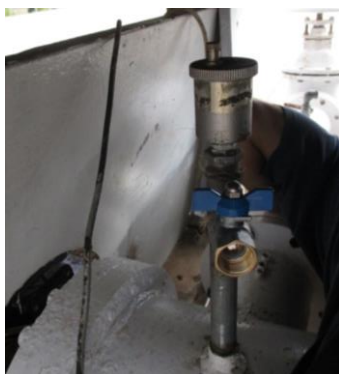
Figura 69 – Instalação do sistema torneira e purga nos permutadores
