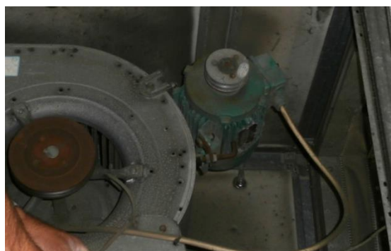
Figura 85 – Limpeza da UTV
