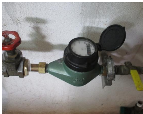
Figura 90 – Montagem do contador volumétrico
