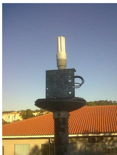
Figura 118 – Instalação do suporte para lâmpada fluorescente compacta
