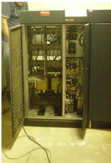
Figura 54 – Remoção da UPS inicialmente instalada no piso 0
