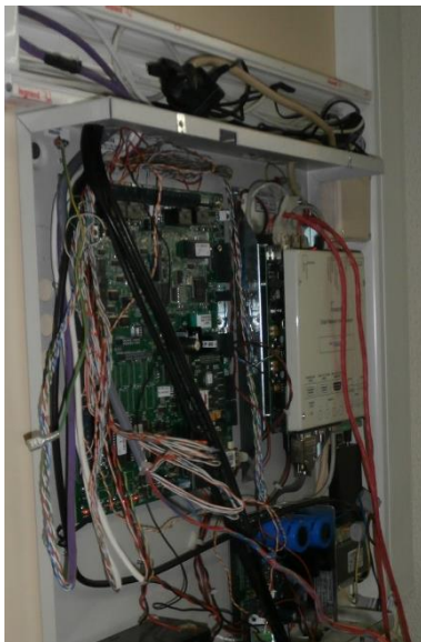
Figura 124 – Estado inicial da caixa de controlo do sistema C.C.T.V.
