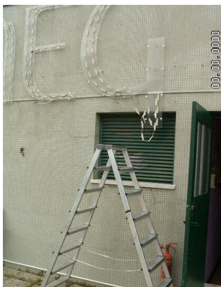
Figura 109 – Reparação dos painéis de LED's do logótipo instalado no piso 4
