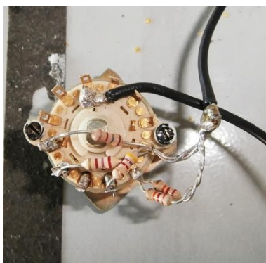
Figura 125 – Botão rotativo instalado para controlo da porta automática
