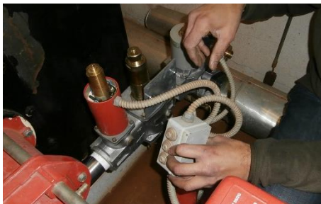
Figura 75 – Montagem da linha de gás
