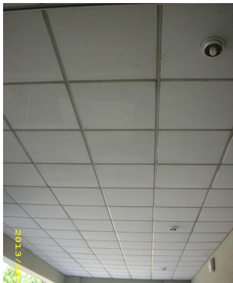
Figura 107 – Zona oeste do telheiro no final da intervenção
