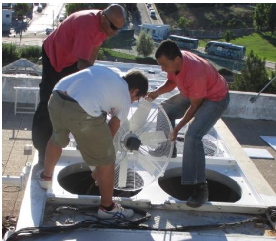
Figura 68 – Instalação dos ventiladores nas respetivas placas de sustentação~
