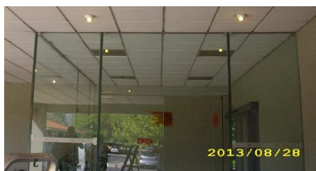
Figura 103 – Zona envidraçada do telheiro antes da intervenção
