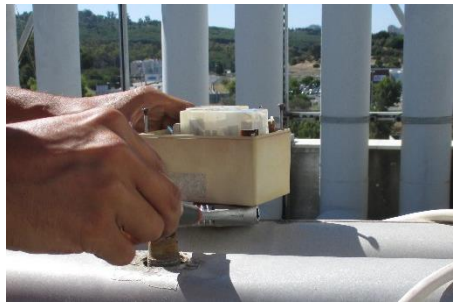
Figura 81 – Remoção das caixas de comando das válvulas modulantes de três vias
