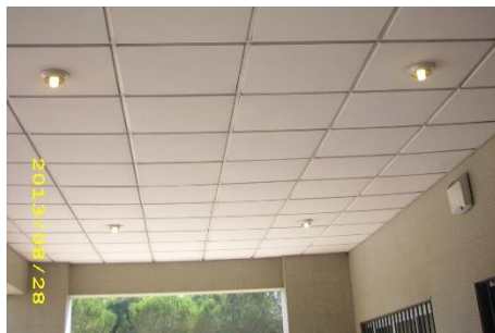
Figura 106 – Zona oeste do telheiro antes da intervenção
