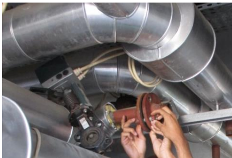
Figura 86 – Alteração do sistema de tubagens e válvulas
