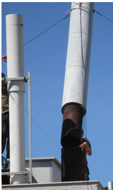
Figura 78 – Remoção da chaminé da caldeira
