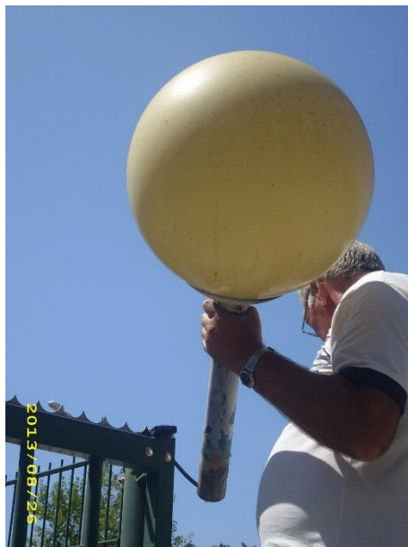
Figura 116 – Remoção dos candeeiros instalados no portão principal
