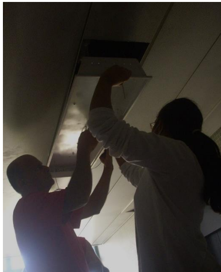
Figura 102 – Substituição dos apliques por uma luminária
