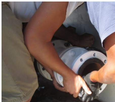
Figura 63 – Montagem do circuito hidráulico
