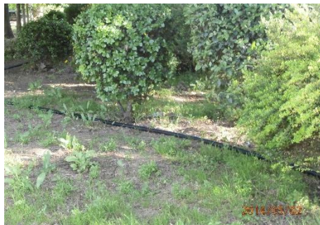
Figura 131 – Shunt hidráulico instalado provisoriamente
