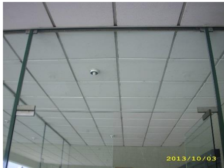
Figura 105 – Estado final da zona envidraçada do telheiro
