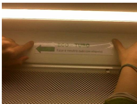
Figura 33 – Colocação de uma etiqueta de indicação da posição correta de instalação de lâmpadas Eco-Tubo®
