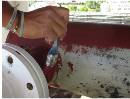
Figura 61 – Pintura do permutador
