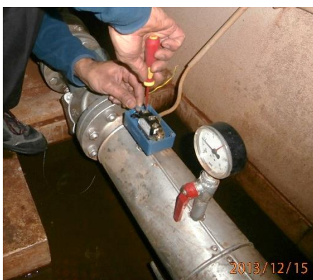
Figura 76 – Instalação do fluxostato da tubagem de água quente
