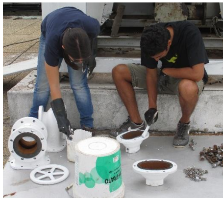
Figura 62 – Pintura de componentes do circuito hidráulico
