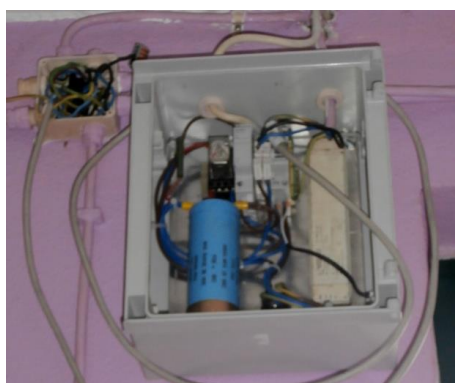
Figura 110 – Novo sistema de alimentação do logótipo instalado no piso 4
