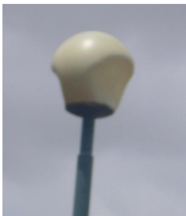
Figura 112 – Exemplo de um globo de proteção amolgado e coluna de sustentação torta
