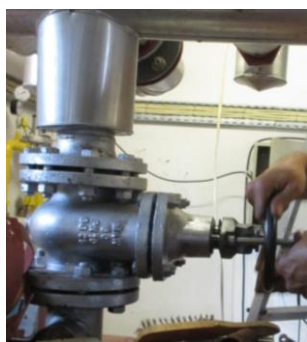
Figura 87 – Colocação do veio da torneira da válvula de cunha de um coletor
