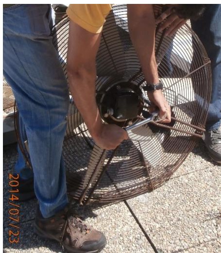
Figura 60 – Desmontagem dos ventiladores
