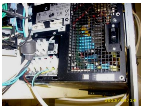
Figura 55 – Reparação das UPSs
