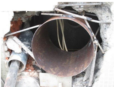
Figura 79 – Colocação de parte da chaminé a sair pela parede
