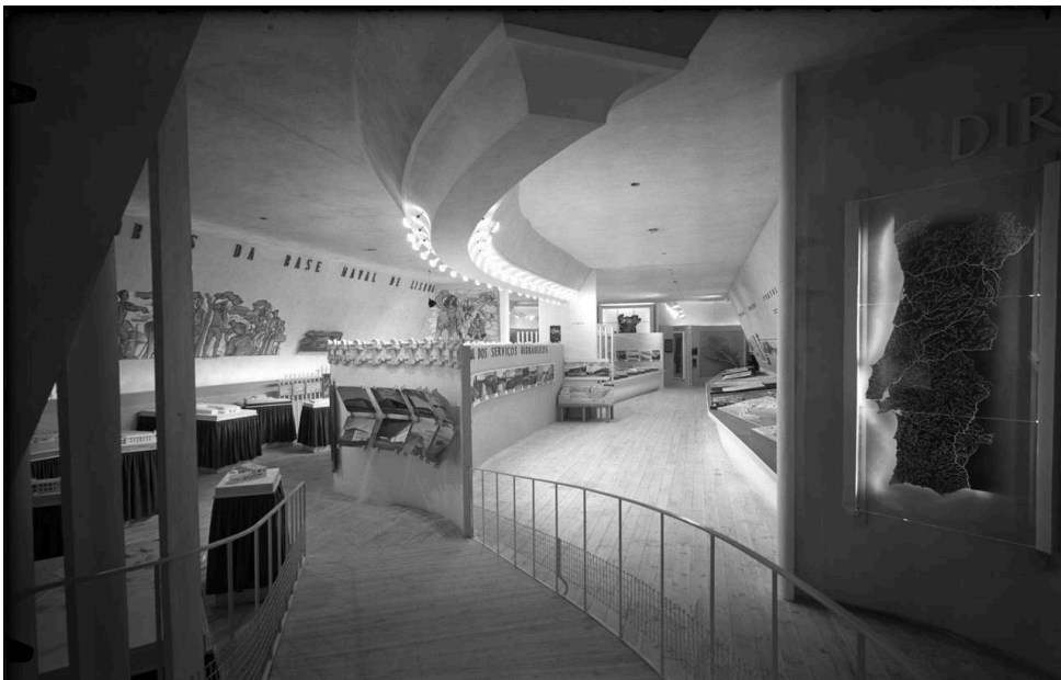
Fig. 4 – Exposição Quinze Anos de Obras Públicas , Secção de Hidráulica, núcleos da Comissão de Obras da Base Naval de Lisboa (lado eq.) e da Direção Geral dos Serviços Hidráulicos (lado dto.), 1948
