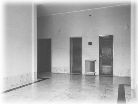
Fotografia n.º 15 – Vestíbulo do novo edifício da Escola Técnica de Enfermeiras.
