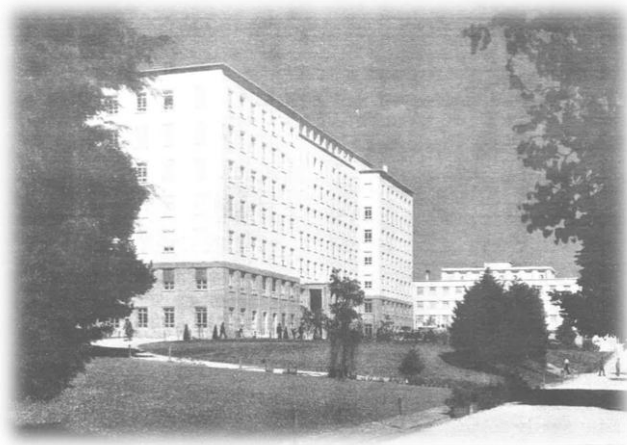
Fotografia n.º 13 – Aspeto do Bloco Hospitalar vendo-se à direita a Escola Técnica de Enfermeiras.
