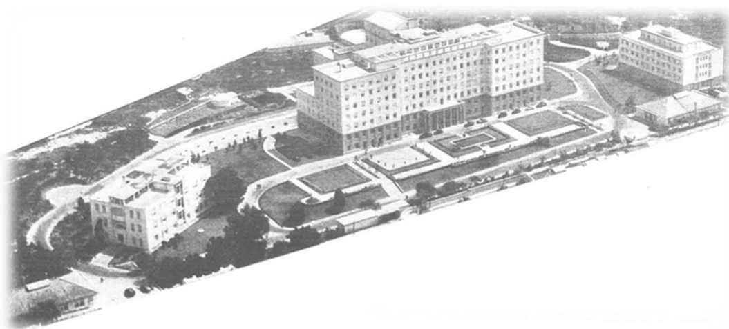
Fotografia n.º 12 – Vista aérea abrangendo os principais edifícios do Instituto.
