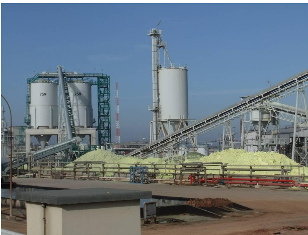
Figura 5.4 – Zona de armazenamento de enxofre processado na RS
