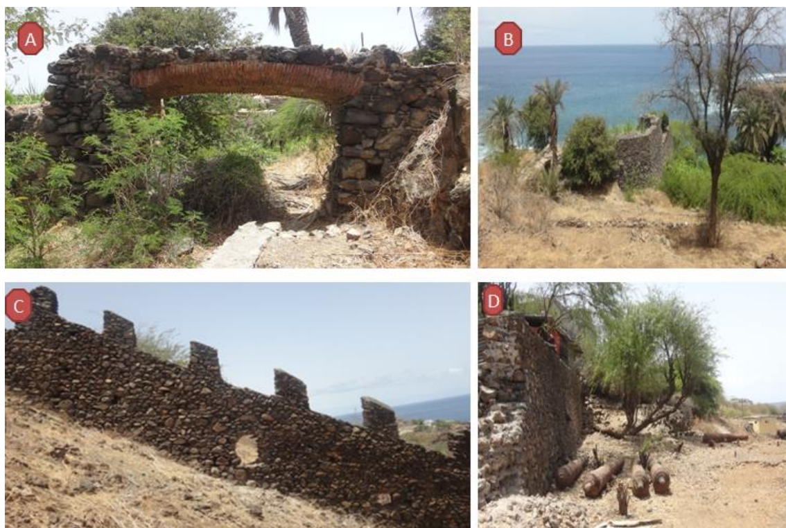
Fig. 18 – Estruturas militares e defensivas na Cidade de Ribeira Grande (Cidade Velha): A - Porta de entrada da cidade do Lado Oeste; B - vista do Forte de São Lourenço; C - vestígios da muralha antiga da cidade; D - vista do Forte de São veríssimo, com canhões no seu interior. (Fotografias: Nireide Tavares, 2016).
