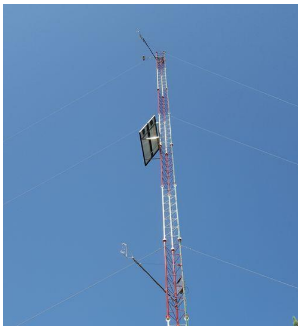
Figura VI. 9: Torre TSE01 [Fonte: (Perdigão Field Experiment 2020)]
