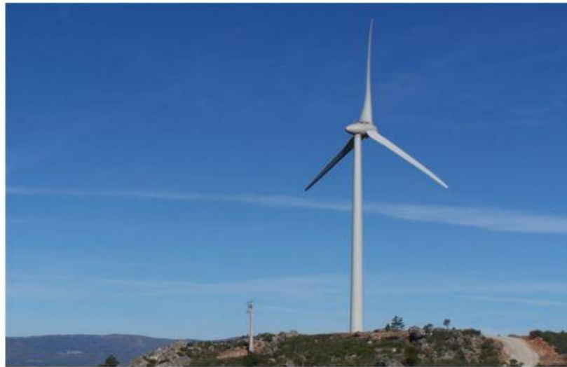
Figura I. 9: Parque Eólico do Perdigão [fonte: (INEGI s.d.)]
