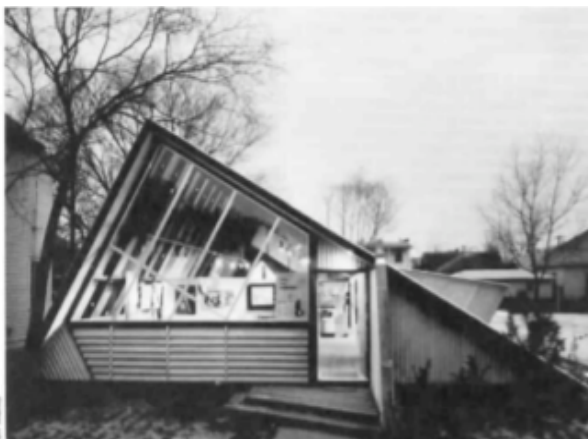
Figura SEQ Figura \*ARABIC22, Museu de Arte Contemporânea, Houston, construído em 1949 e atualmente demolido, imagem retirada de: http://offcite.org/wp-content/uploads/sites/3/2010/03/SeeingWasBelieving_Cite40.pdf
