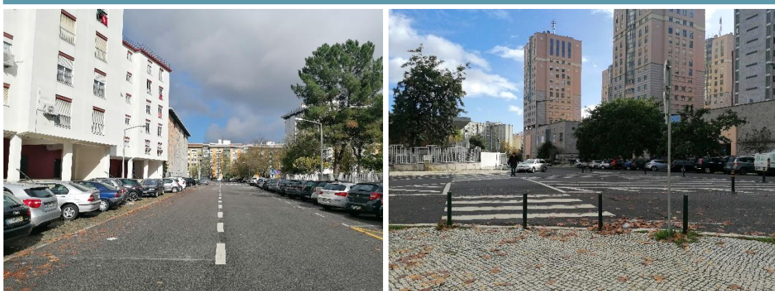
Figura 56 – Rua Cidade de Moçâmedes
