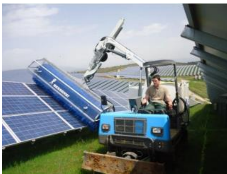
Figura 26 - Sistema de limpeza de parques solares com maquinaria pesada [79].
