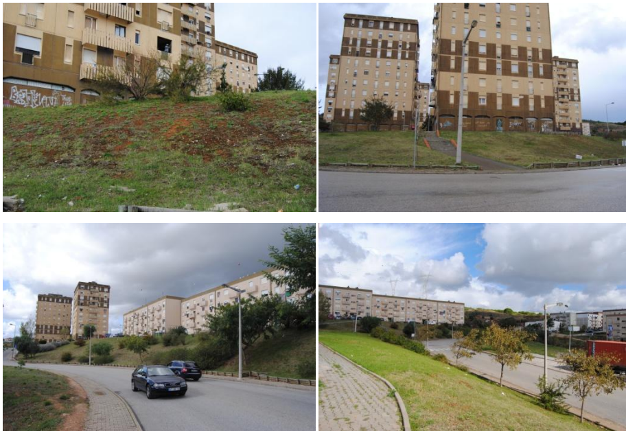
Figura 14 – Situação actual dos limites - taludes (foto de autor, 2011)
