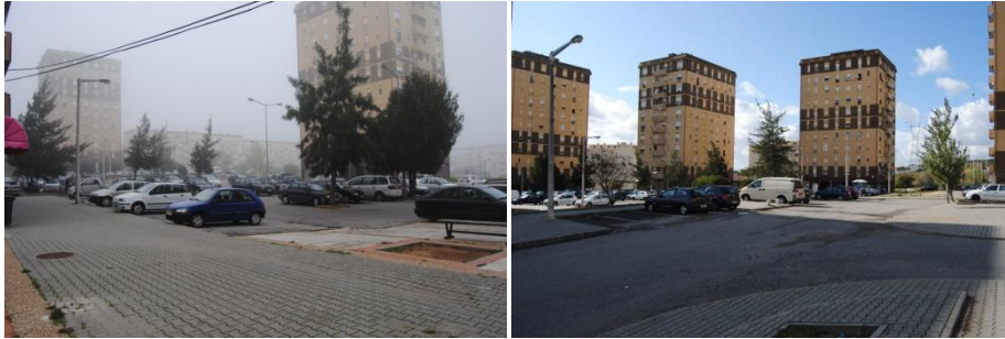
Figura 12 – situação actual - estacionamento central (foto de autor, 2011)
