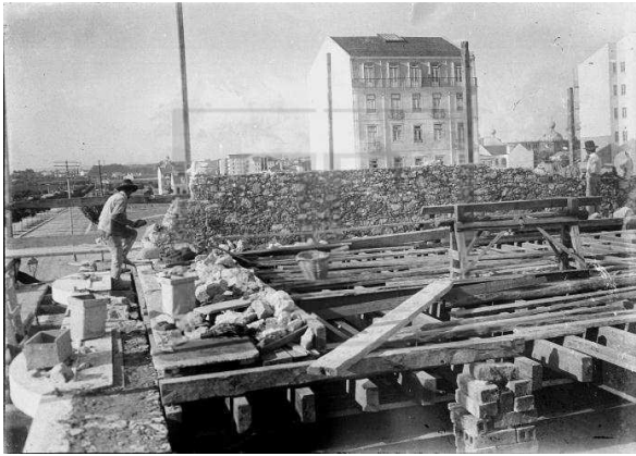
Fig. 6 | Avenidas Novas em construção.
