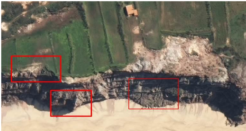
Ilustração 10 - Características de instabilidade nas arribas do litoral de Torres Vedras.
