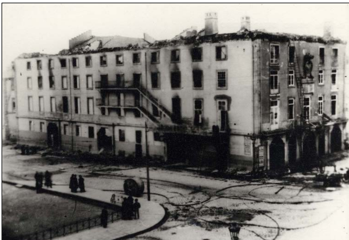
Figura 38 – No rescaldo do incêndio do Teatro de S. João, em 1908 (A. H. M. P.)
