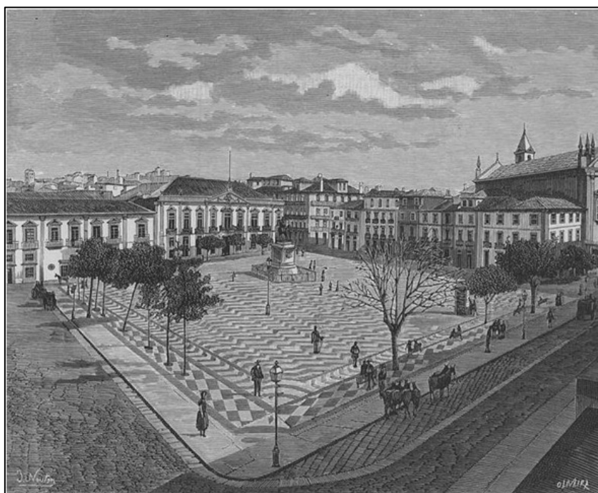
Figura 7 – Vista geral da Praça D. Pedro. ( O Ocidente , nº 286, 12.1886, p. 269)
