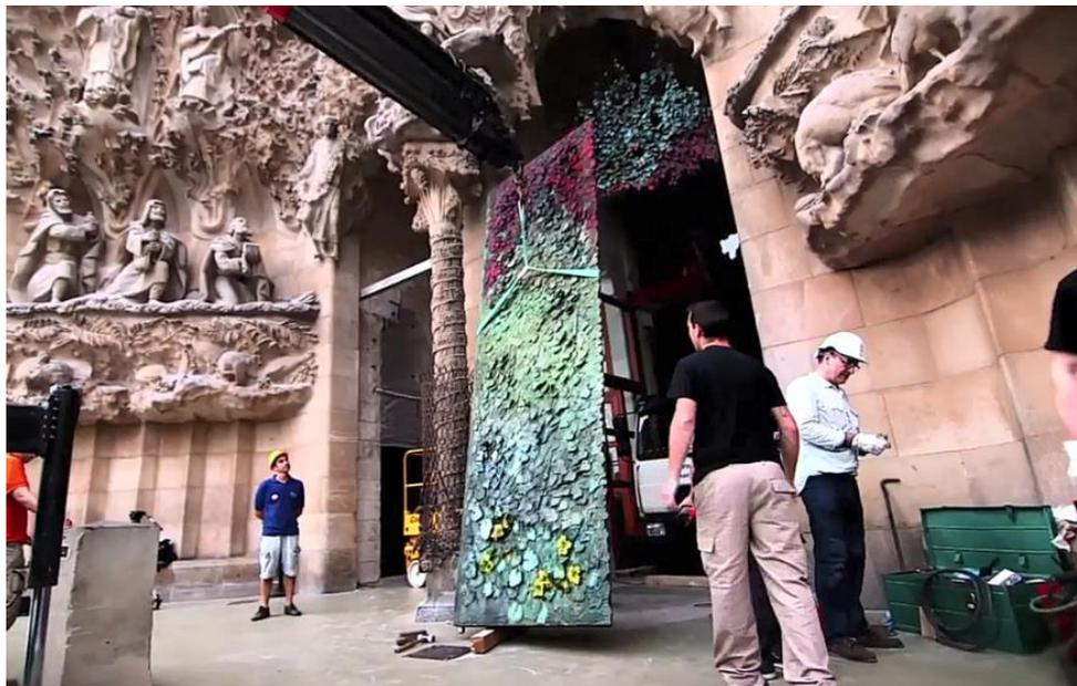
Fig. 65- colocação da Porta na Fachada
