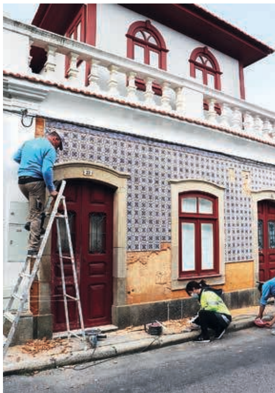
12. Restauration d'une façade d'azulejos à Ovar.
