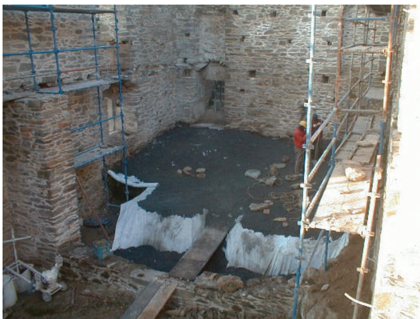
Aspecto da intervenção no Real Filatório
