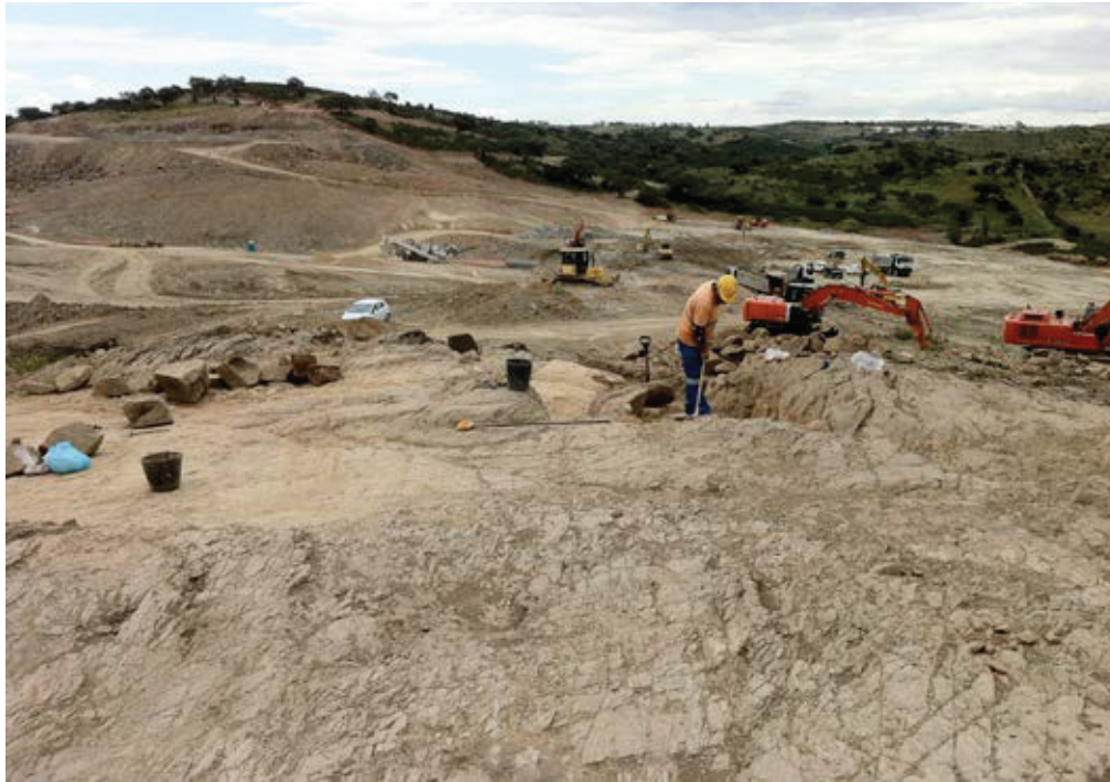
Foto 42. Fase final dos trabalhos. Desmontagem das estruturas.
