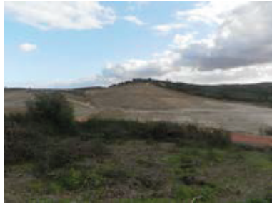
Foto 2. Enquadramento do local de escavação do reservatório.
