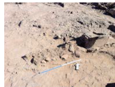
Foto 40. Desmontagem do muro intermédio entre compartimentos A e C.
