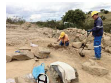
Foto 41. Perspectiva do desmonte do monumento.
