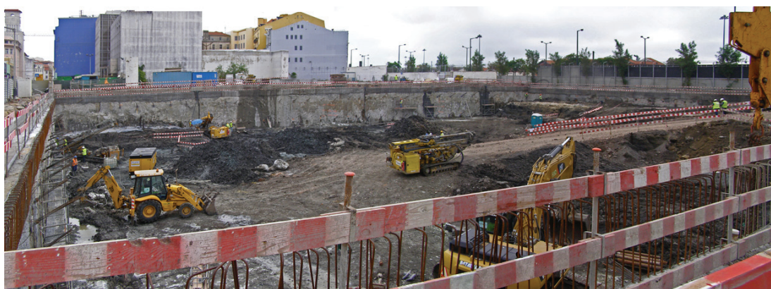
Figura 2 – Vista geral da obra da Nova Sede da EDP, Cais do Sodré.
