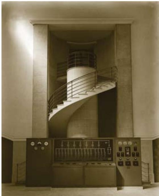
Quadro eléctrico de comando e medida da Estação Elevatória dos Olivais
