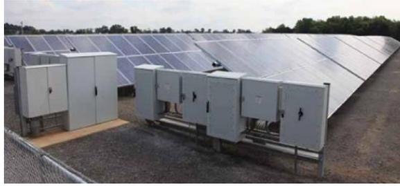
*Figura 3.3 – Inversores de um parque solar (Agora, o progresso na produção de energia solar fotovoltaica!, 2012)*
