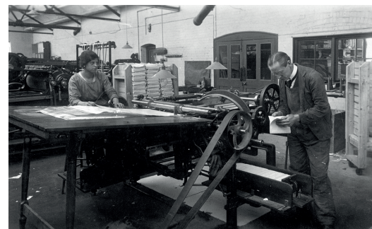
FIGURA 17 Trabalhando na imprensa na década de 1920 em Stanborough Press. Fonte: Stanborough Press Archives, s.d.
