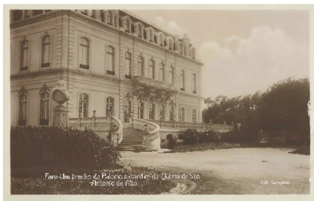
Figura 83 - Fachada lateral Noroeste do Palácio do Alto (Fonte: Coleção José Brito)
