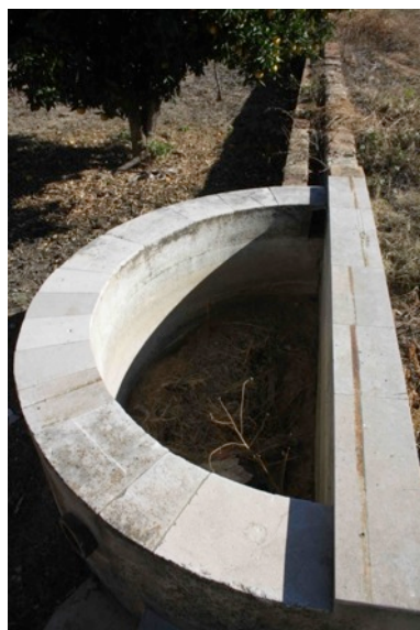
Figura 86 - Recuperação de uma regadeira (Fonte: Autora)
