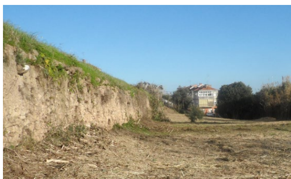
Figura 28: Muro adjacente ao tanque recente, Quinta de Valflores (Fonte: Arquivo ADPAC)
