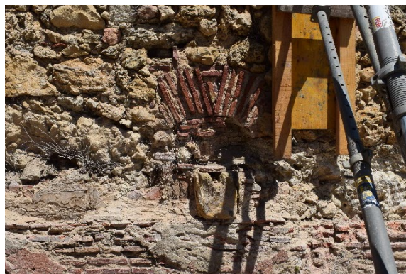
Figura 47: Vestígios bica do tanque T1, Quinta de Valflores © Autora, 2021
