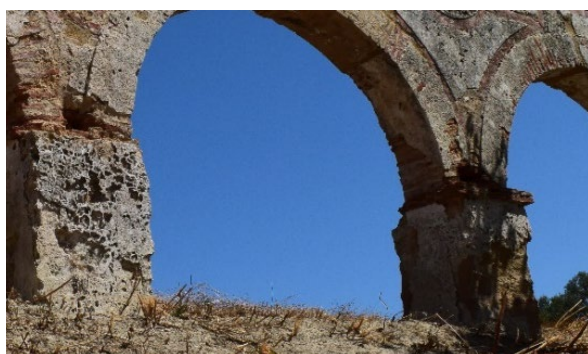
Figura 27: Local de encaixe das traves no aqueduto, Quinta de Valflores © Autora, 2021
