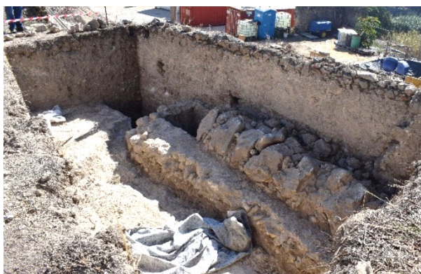
Figura 44: Último troço da galeria subterrânea, Quinta de Valflores © Autora, 2021
