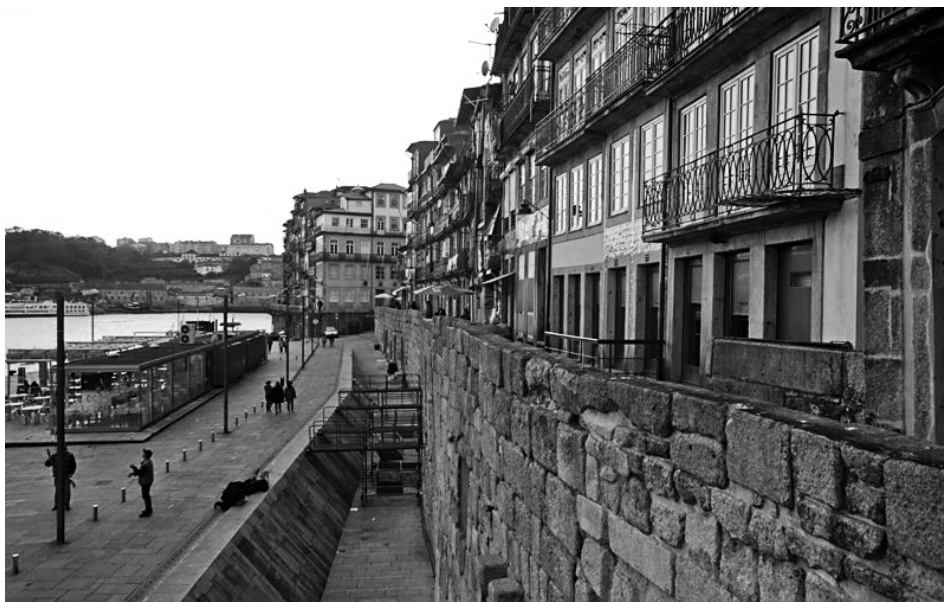
31. Muro dos Bacalhoiros, no Cais da Estiva, Porto
