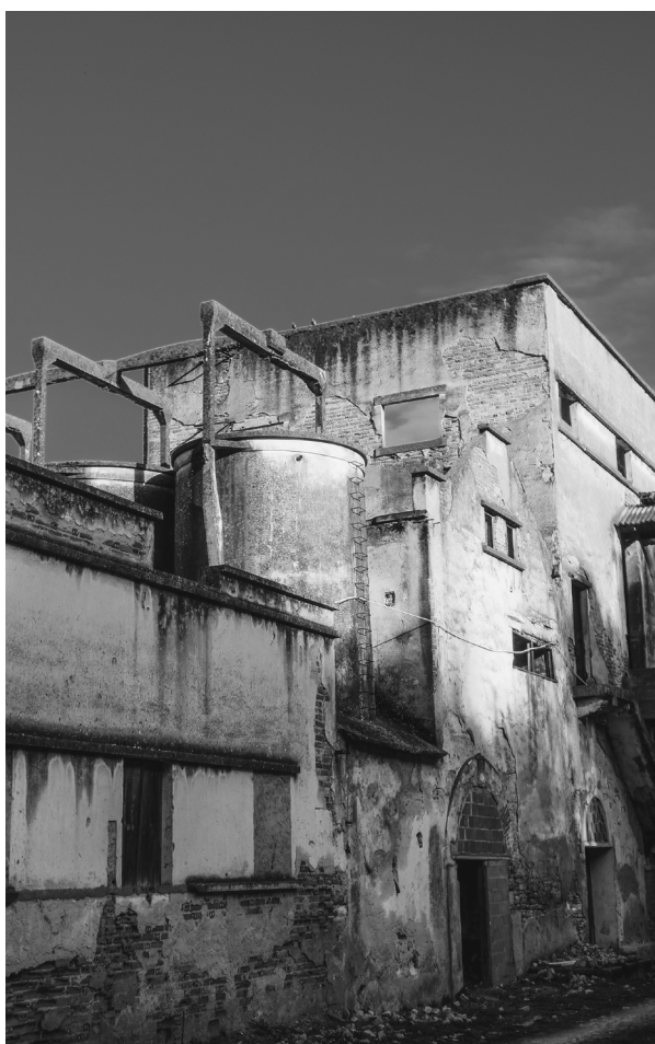
45. Ruína da Antiga Fábrica de Sabão em Alfange, Santarém. Fotografia do Autor
