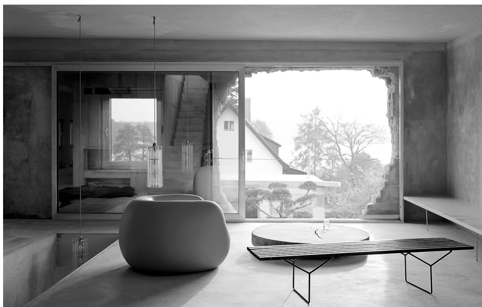
68. Vão resultante da destruição e rasgamento das paredes, Antivilla. Fotografia de Erica Overmeer
