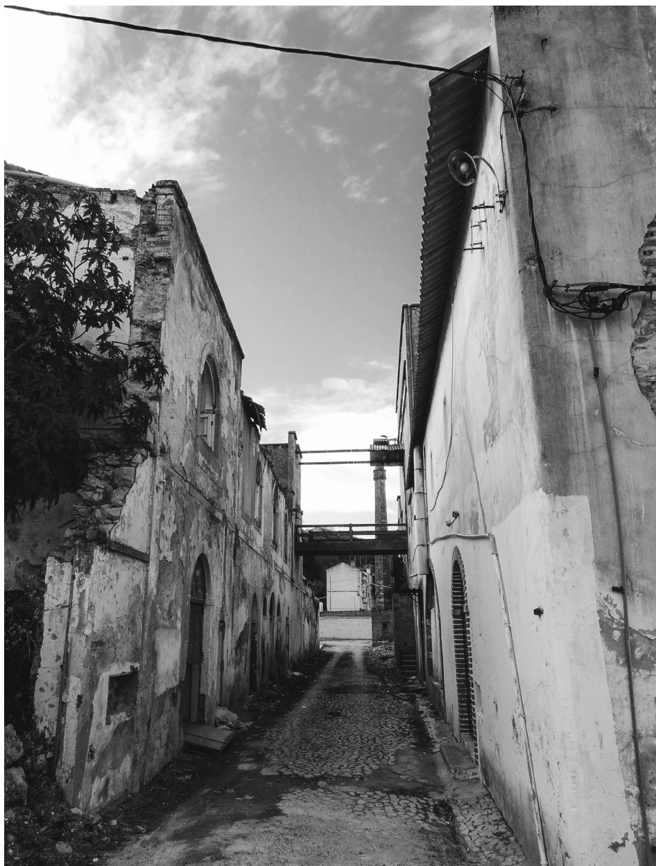
126. Antiga Fábrica de Sabão de Alfange, rua interior
