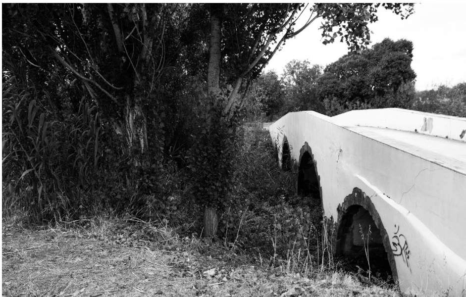
159. Ponte do Alcorce, 2020
