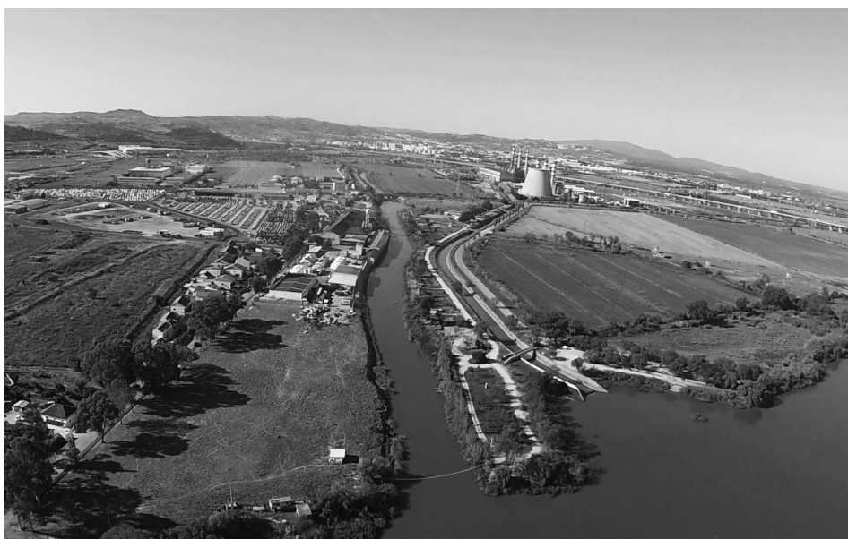
78. Vista aérea da Vala do Carregado
