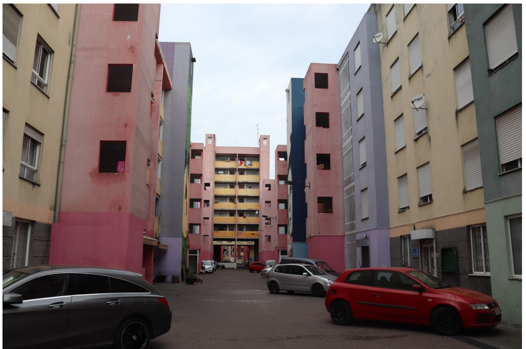
Figura 61. Fotografia do “interior” do Bairro do Cabrinha, sua degradação, 2020.
