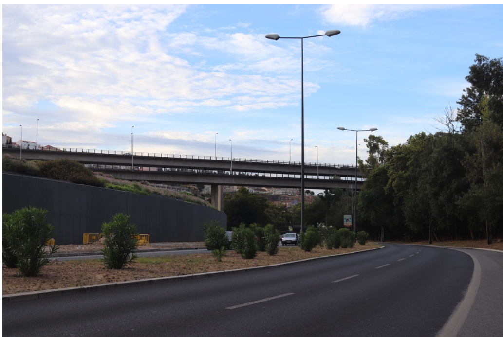
Figura 58. Fotografia da Avenida de Ceuta perto da ETAR de Alcântara, 2020.
