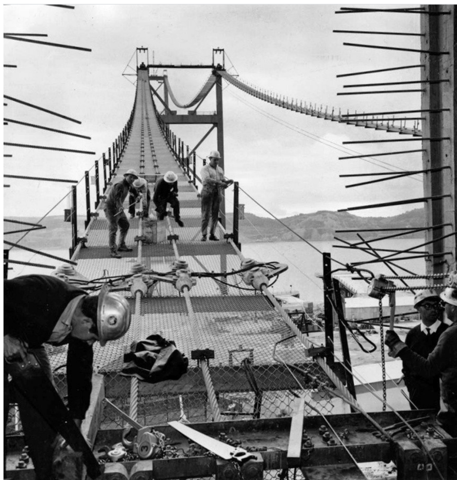
Figura 38. Trabalhadores da Ponte Salazar. Fotógrafo n.i., Arquivo Municipal de Lisboa
