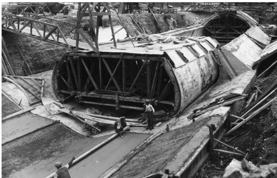
Figura 26. Caneiro de Alcântara, obras de cobertura da Ribeira de Alcântara, Lisboa 1945. Eduardo Portugal, in a.f. C.M.L.
