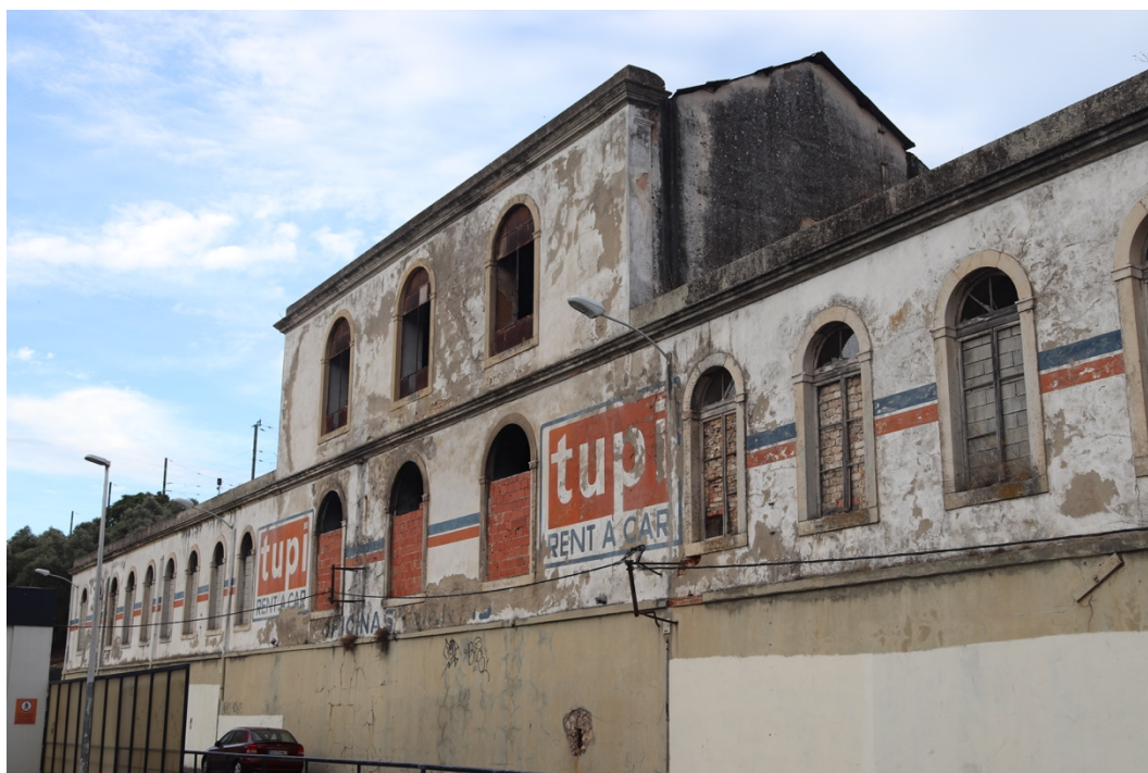
Figura 67. Fotografia do Edifício em ruínas da Companhia Lisbonense de Estamparia e Tinturaria de Algodões, 2020.
