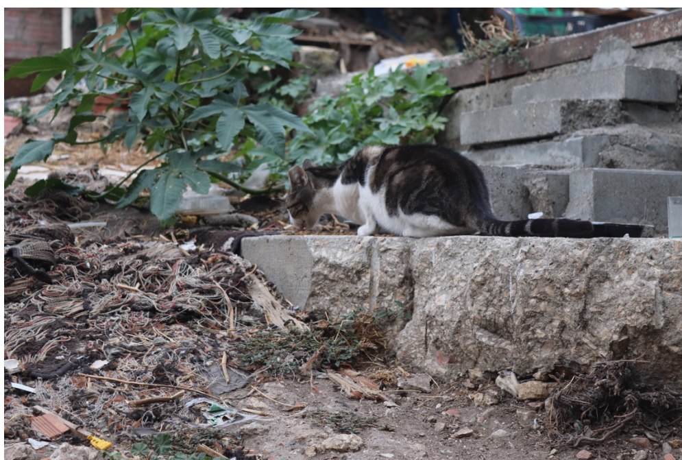
Figura 85. Fotografia da falta de salubridade da encosta do Bairro da Quinta do Cabrinha, 2020.
