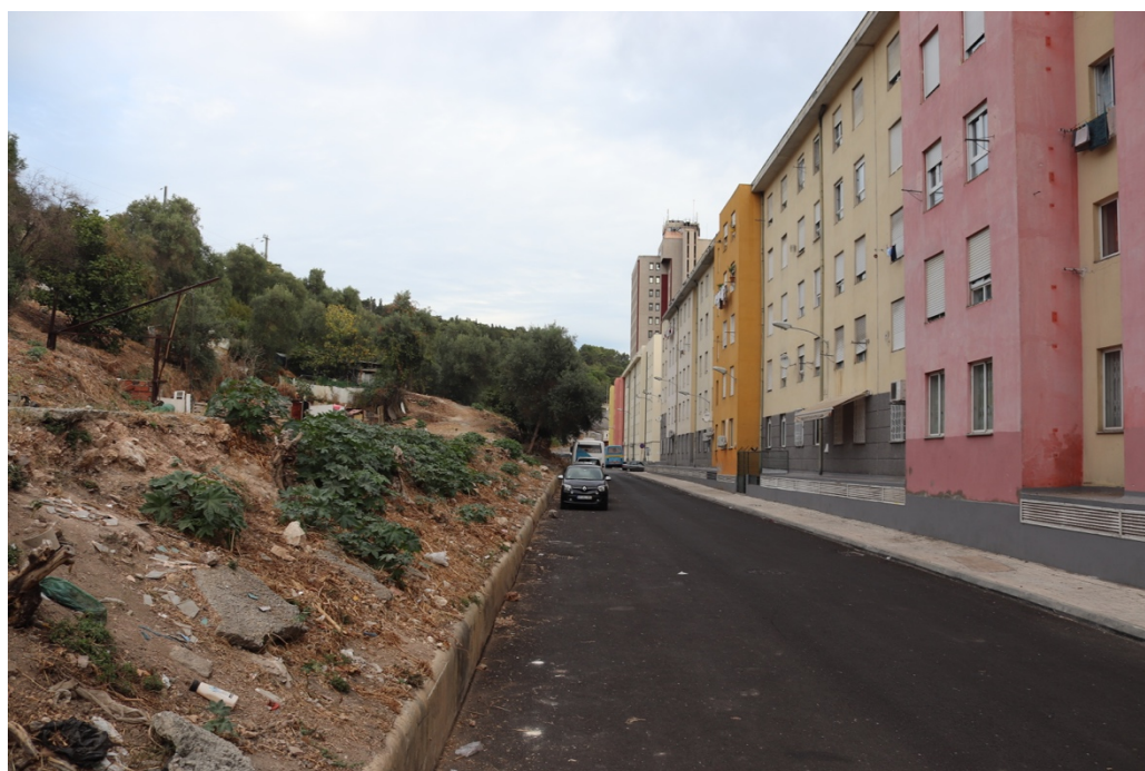
Figura 80. Fotografia da degradação do Bairro da Quinta do Carbinha, 2020.
