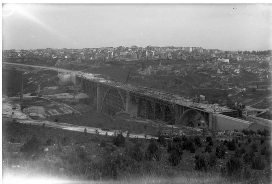
Figura 33. Viaduto Duarte Pacheco em construção, 1943. Fotógrafo n.i., in a.f. C.M.L.
