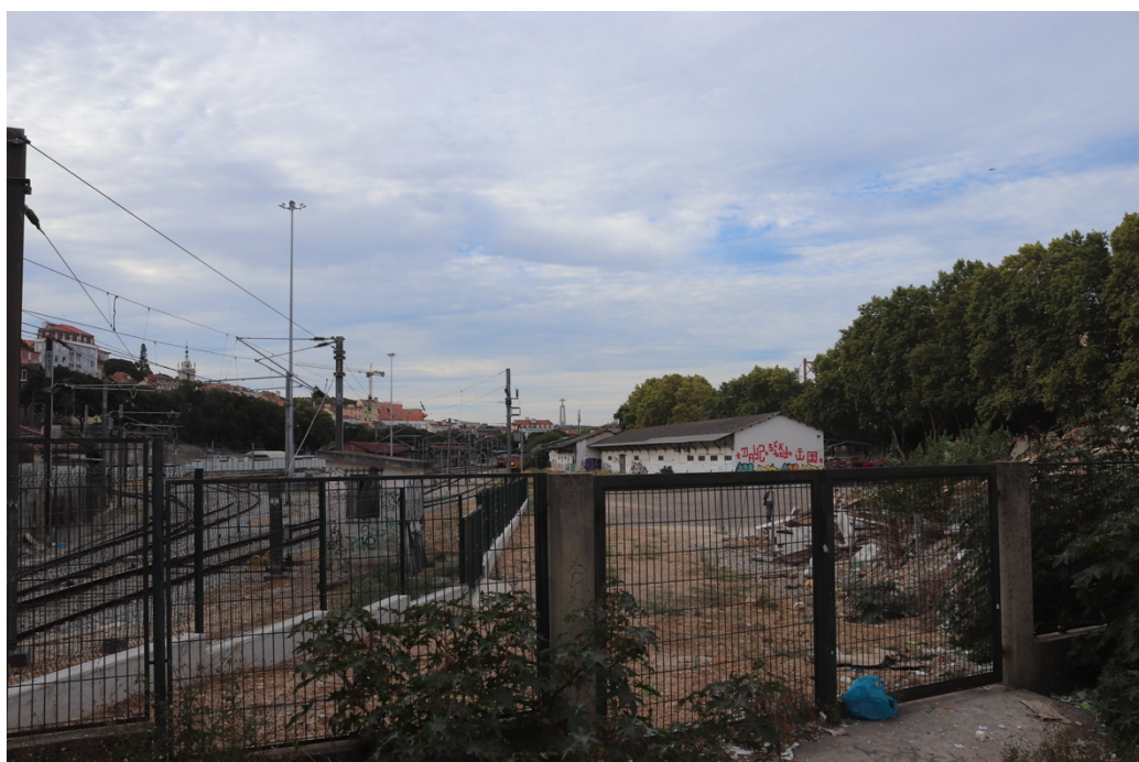
Figura 88. Fotografia da falta de salubridade dos Caminhos de Ferro, 2020.
