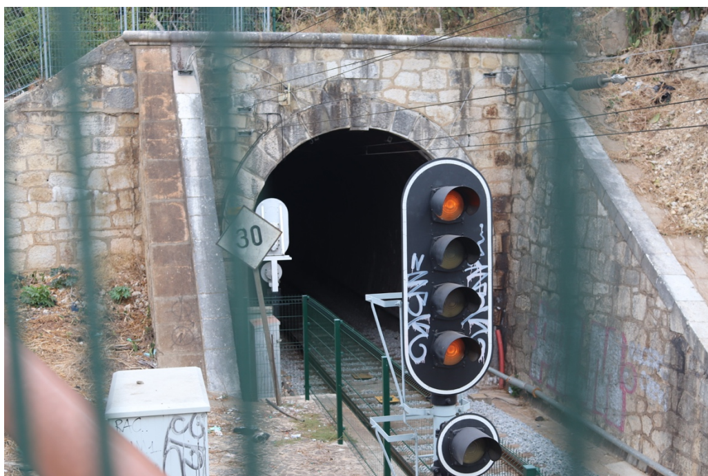
Figura 78. Fotografia do Túnel de Alcântara, 2020.
