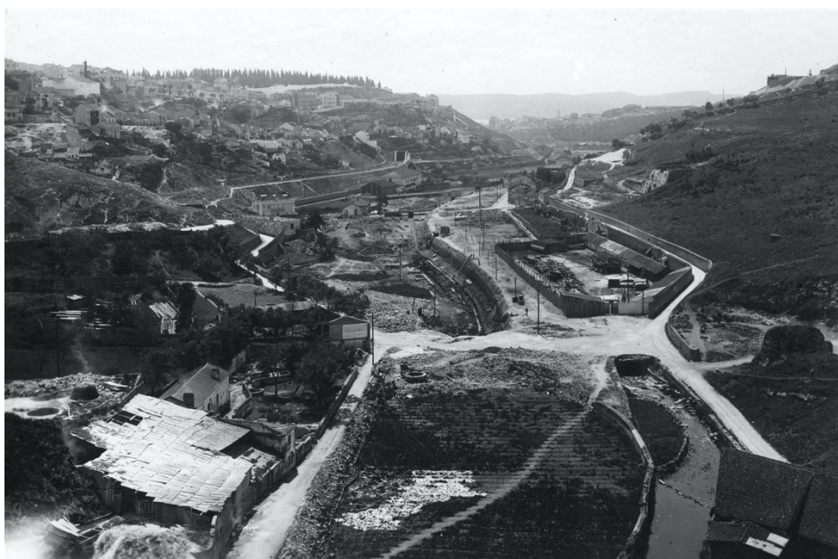
Figura 25. Vista desde o viaduto Duarte Pacheco, obras de encanamento da ribeira de Alcântara, Lisboa 1945. Eduardo Portugal
