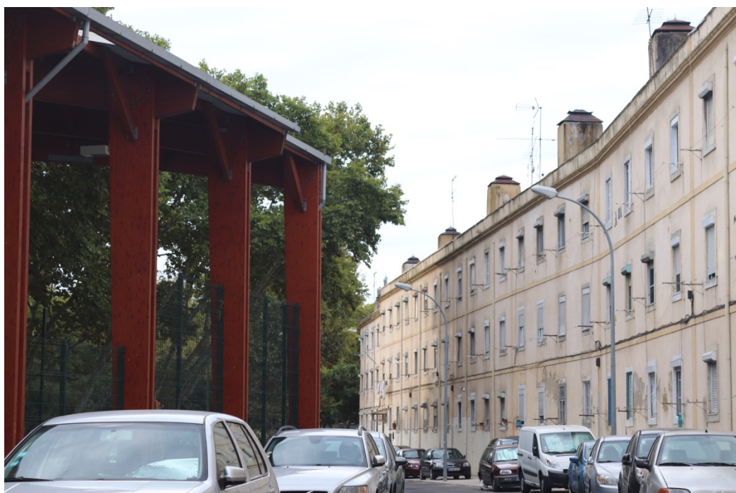
Figura 66. Fotografia do Edifício do Cabrinha, 2020.
