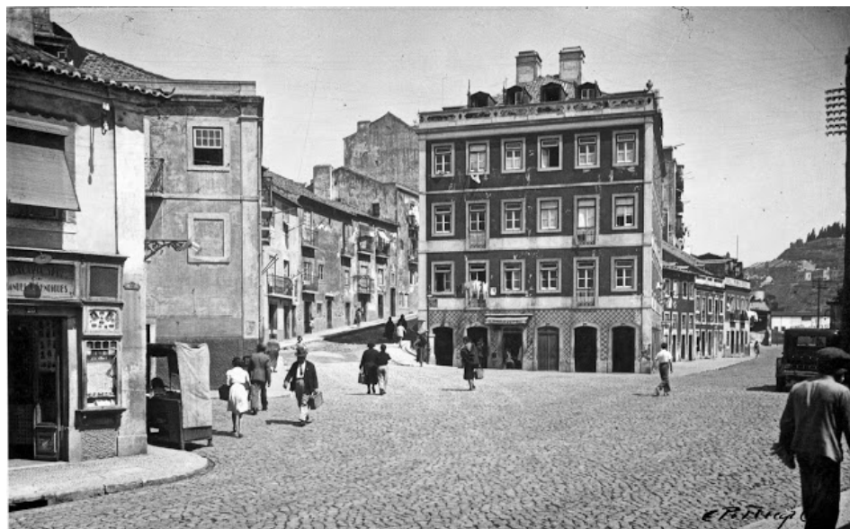
Figura 19. Rua da Fábrica da Pólvora de Alcântara, Lisboa 1940. Eduardo Portugal, Arquivo Municipal de Lisboa
