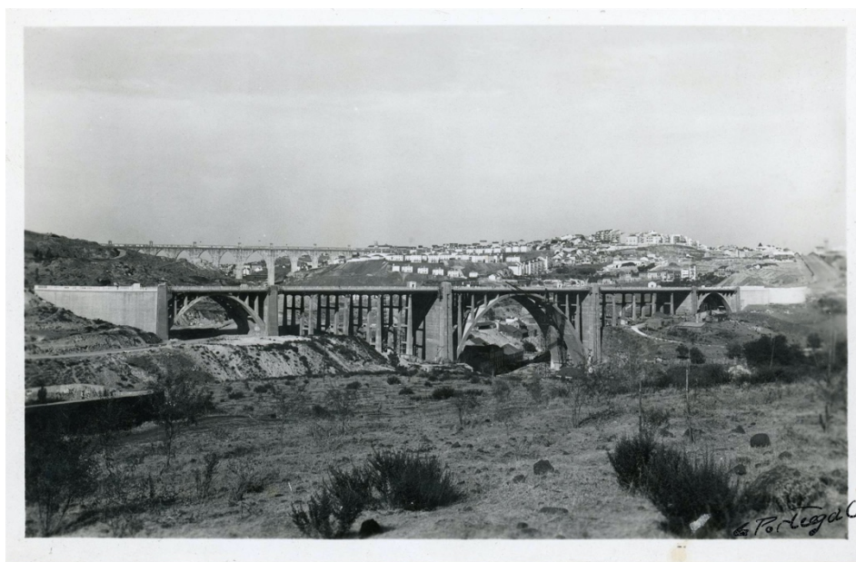
Figura 32. Viaduto Duarte Pacheco, 1941. Eduardo Portugal
