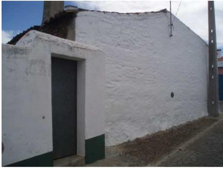
Figura 13 (foto do autor) – O reboco a cal branca permite quase sempre perceber a textura pedregosa que forma as paredes.
