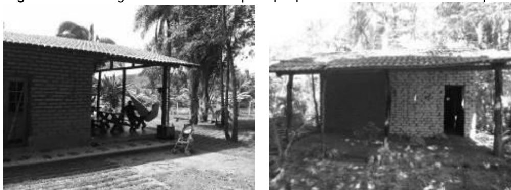
Figura 99 - Prolongamento do telhado principal para inclusão da varanda do Tipo B.
