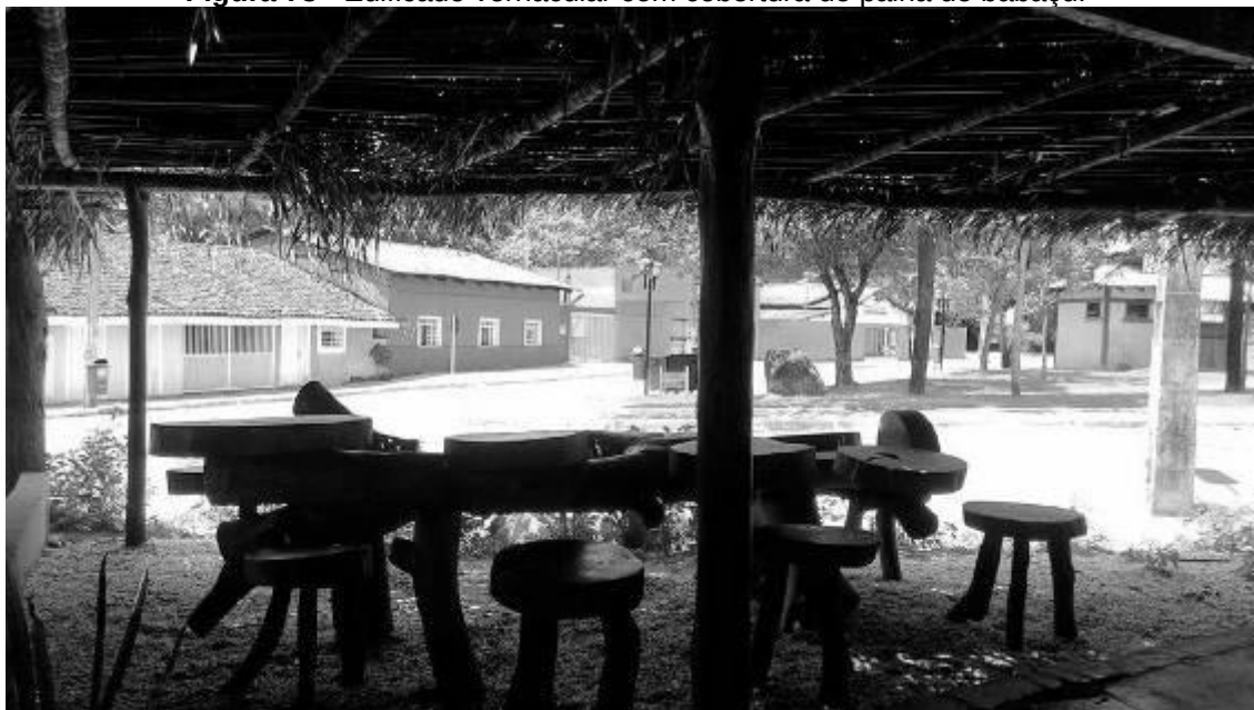
Figura 73 - Edificado vernacular com cobertura de palha de babaçu.
