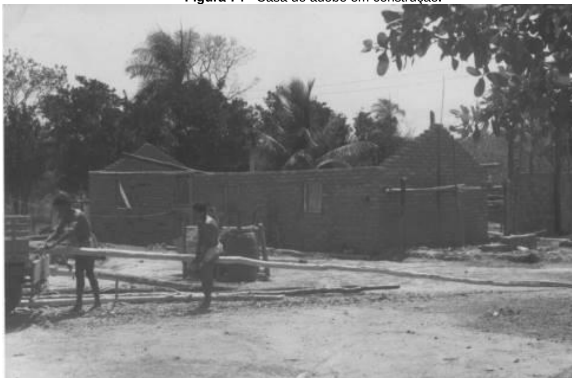
Figura 74 - Casa de adobe em construção.
