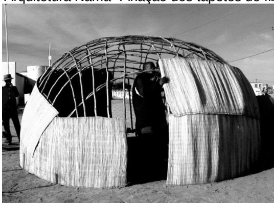
Figura 4 - Arquitetura Nama- Fixação dos tapetes de fibra vegetal.
