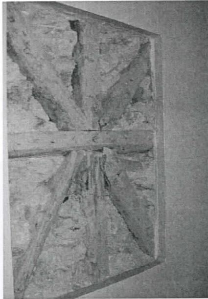
Fig. 4 Pormenor de encaixe de estrutura pombalina
