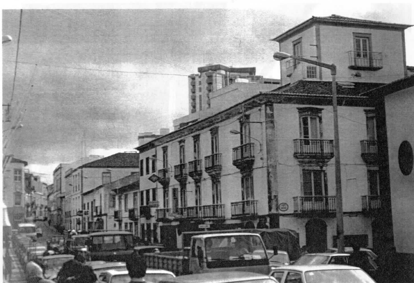
FIG.149 - Tenerife: Garachico, solar com "torre" na c/ Esteban de Ponte. In FERNANDES [213] Canárias, ficha n.188
