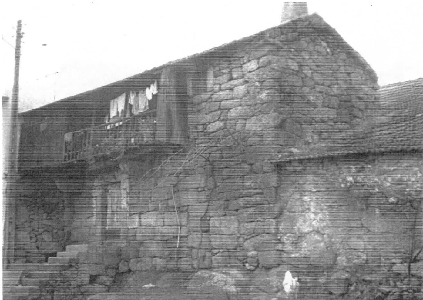
FIG.126 - Trás-os-Montes: casa em Boticas
