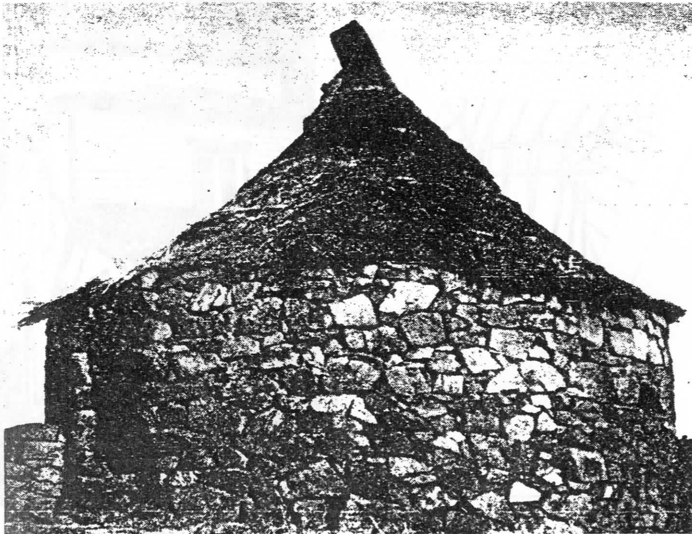
FIG.246 - Tavira (lugar de Santa Maria), abrigo. In OLIVEIRA [et al.] [94] Arquitectura...Pág.20
