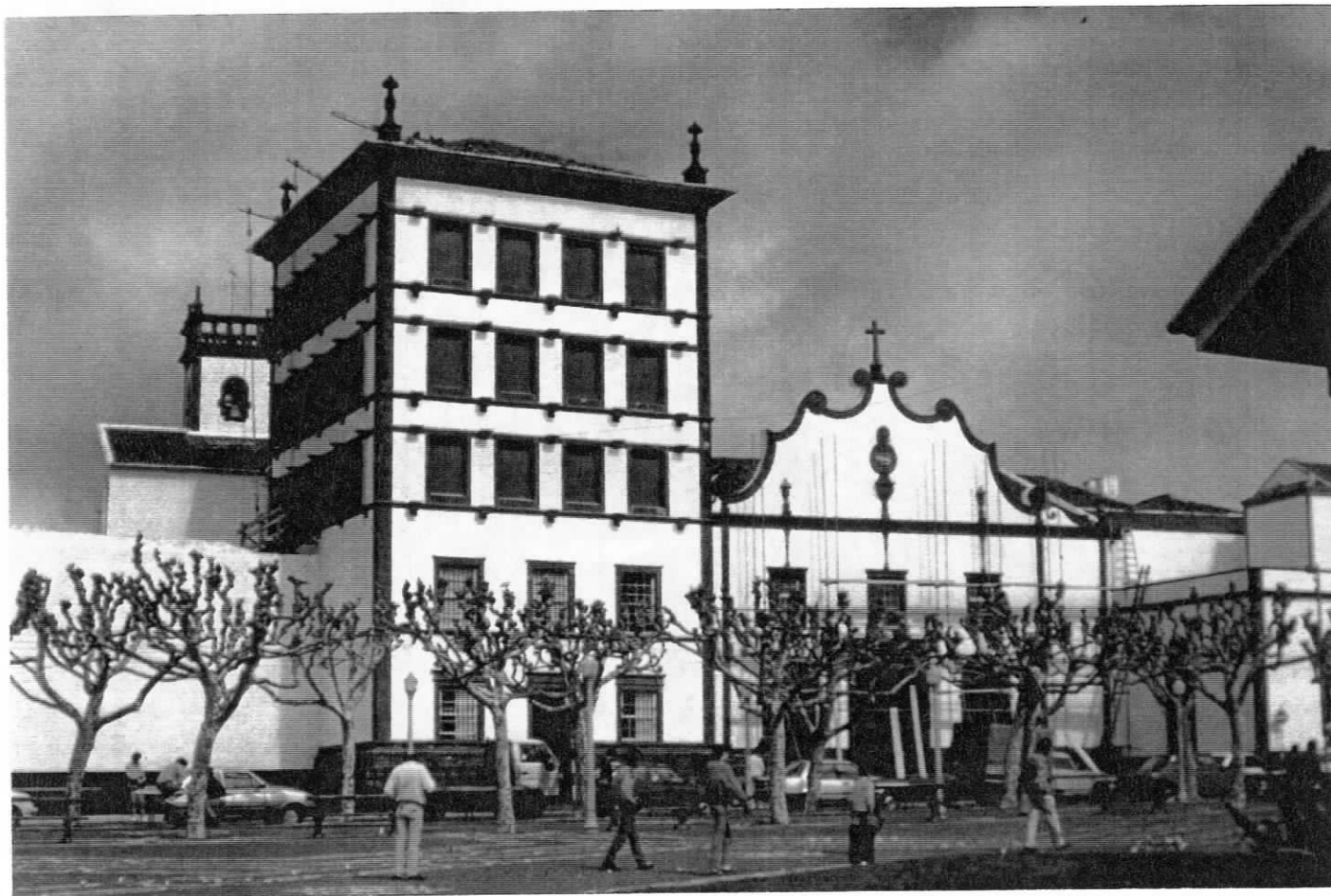
FIG.146 - Ponta Delgada: convento de Santa Clara, com a "torre de rótulas"
