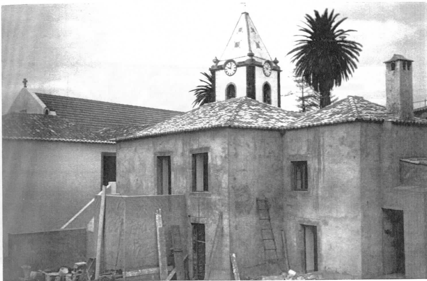
FIG. 265 - Porto Santo, Vila Baleira, casa dita "de Colombo": à esquerda, o balcão e as escadas
