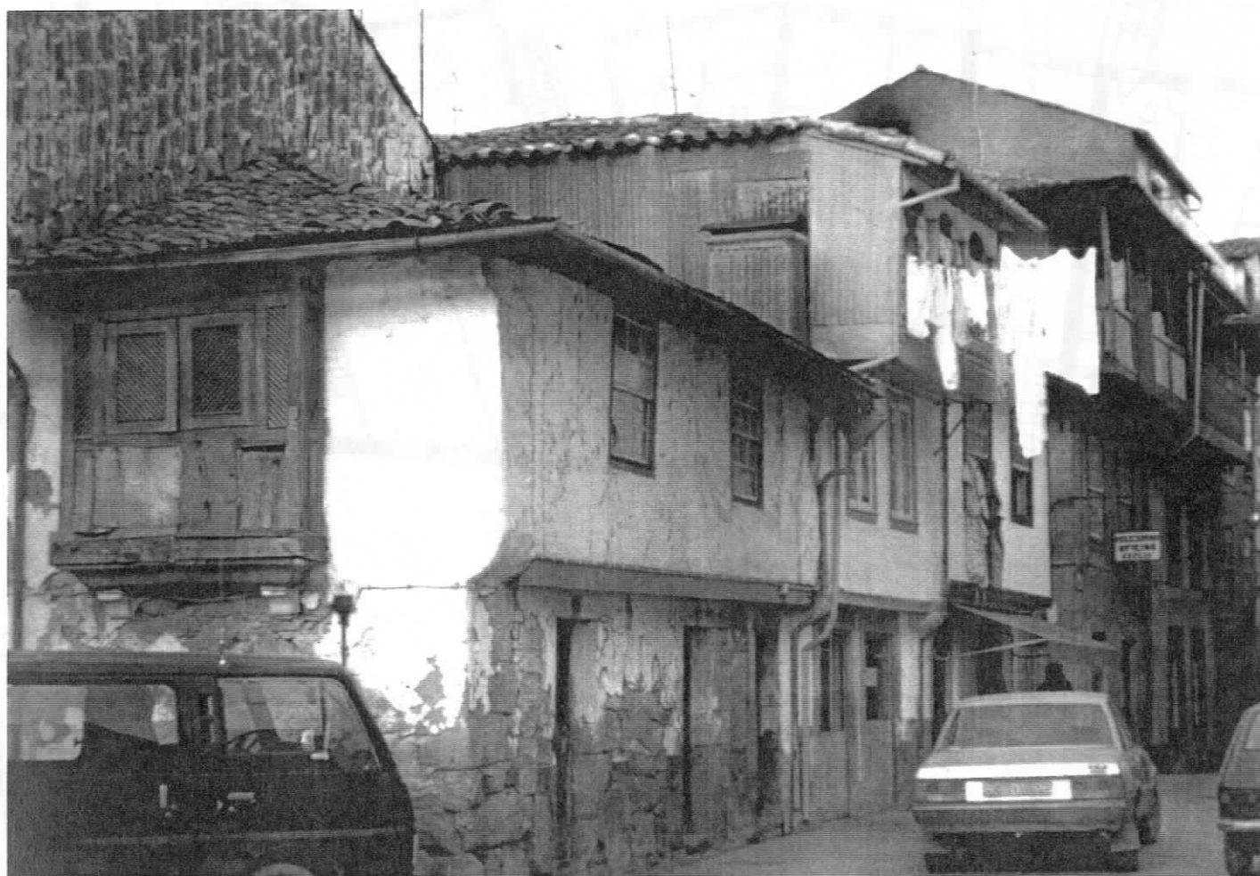
FIG.117 - Chaves, rua no centro, junto à câmara (1985). A esquerda da imagem, um rotulado de madeira em edifício com "andar de ressalto"
