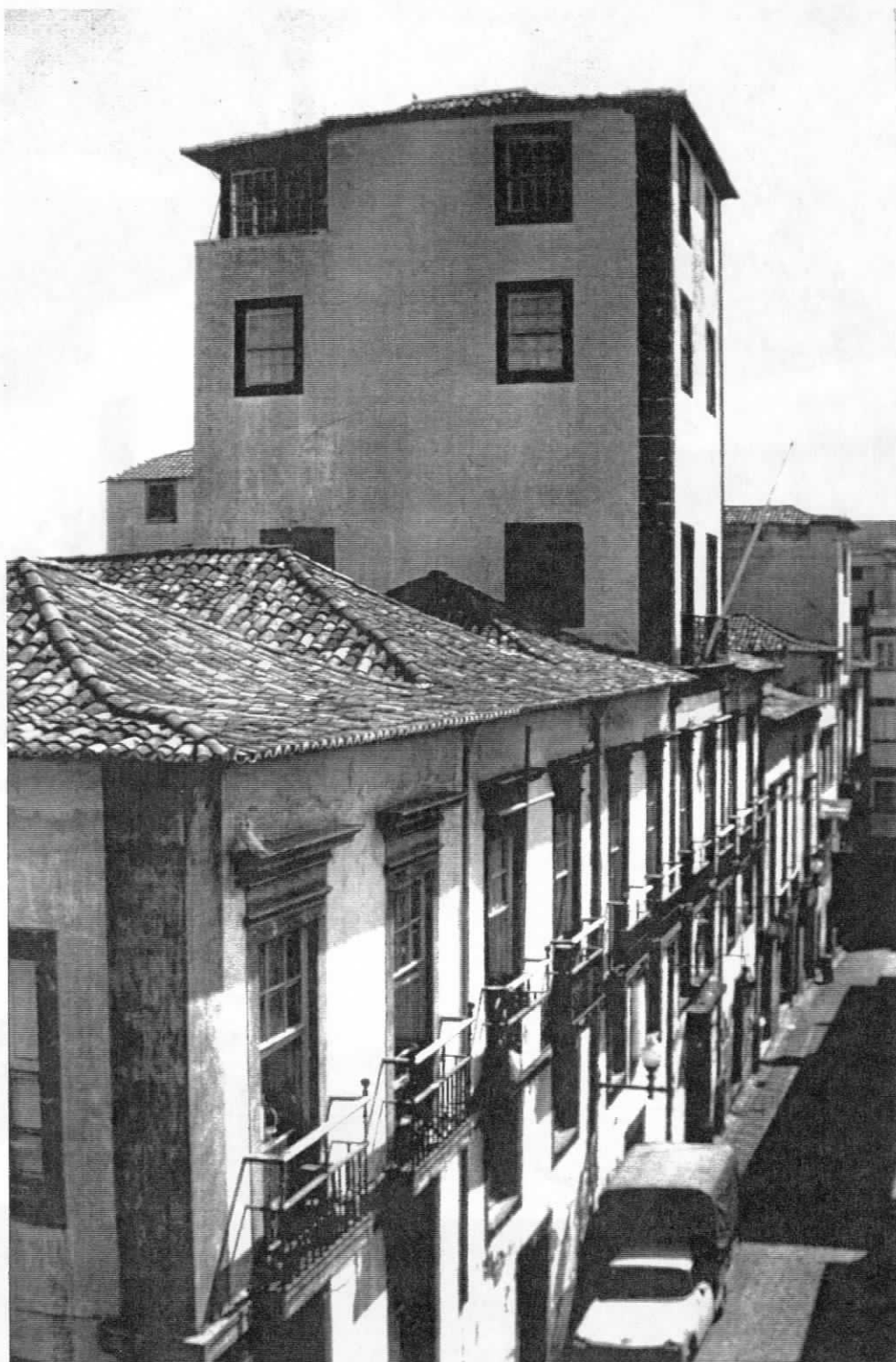
FIG.140 - Funchal: Solar na rua do Bispo: telhados múltiplos e uma característica "torre de mirar"
