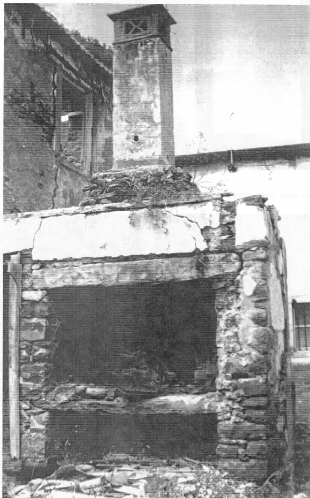
FIG.273 - Ilha da Madeira, Porto da Cruz. Ruínas de um conjunto de lareira, forno e chaminé
