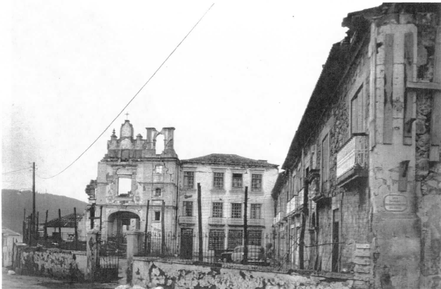
FIG.20 - Angra: ruínas do sismo de 1980
