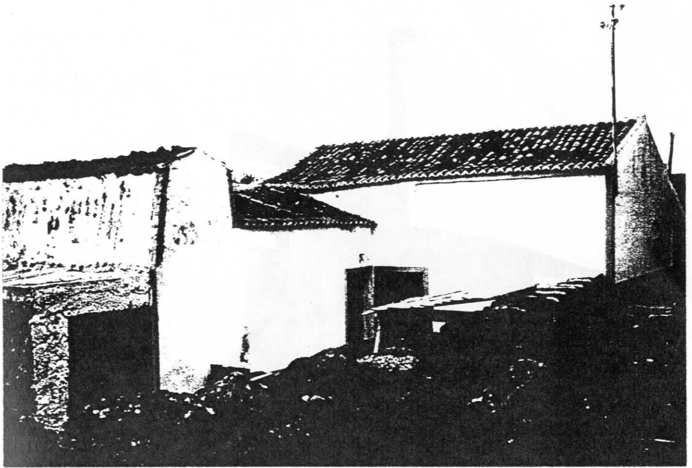
FIG.284 - Graciosa, Carrapacho: a chaminé à largura da cozinha. In FERNANDES [et al.] [210] Açores, ficha n.104. Arquivo
