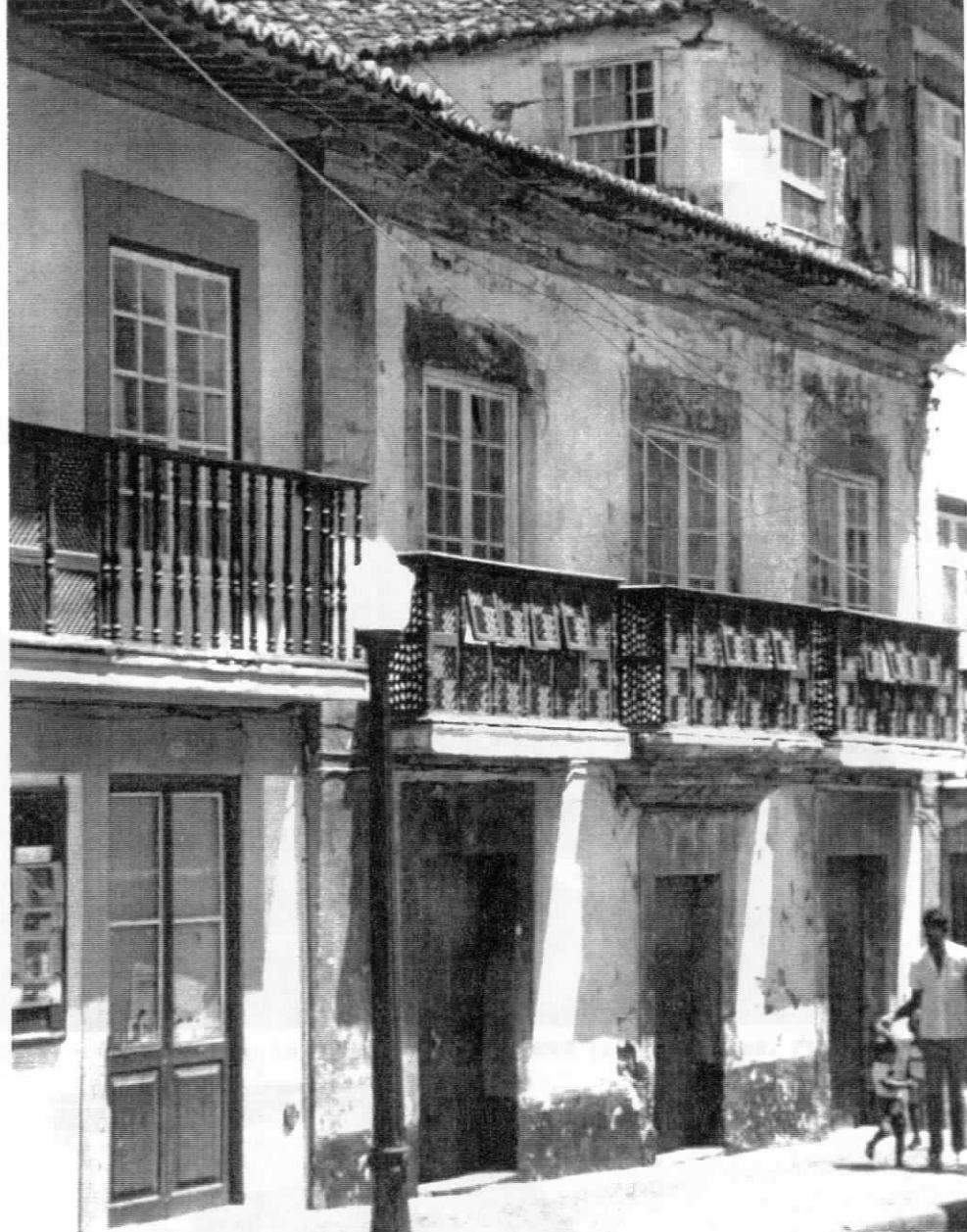
FIG.198 - Angra, casa com rótulas móveis na rua Direita
