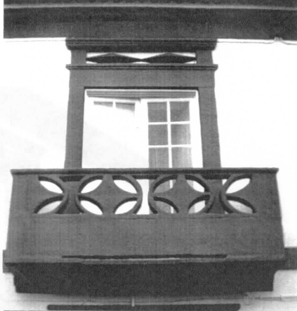
FIG.175 - São Miguel, Ribeira Grande. Casa na rua do Passa1
