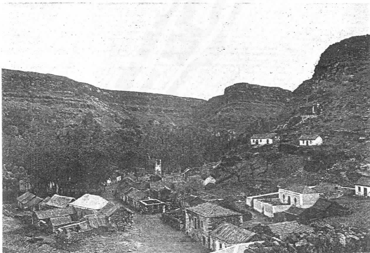
FIG.111 - Cabo Verde, ilha de Santiago. In AMARAL [108] Santiago...Estampa XXXIX. Duas vistas das ruínas da cidade da Ribeira Grande.
