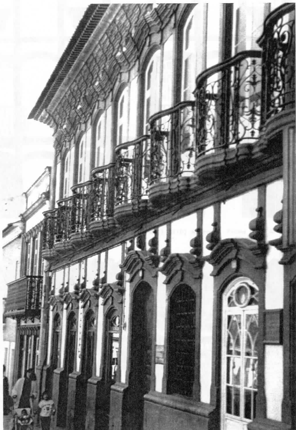
FIG.192 - Angra, "casa do Contratador Prudência", rua Direita
