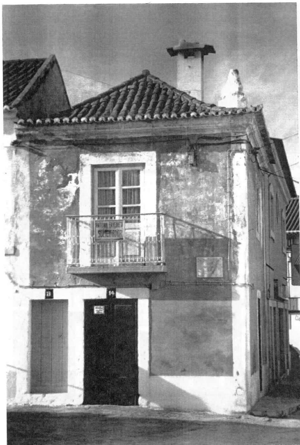
FIG.113 - Moita: casa com telhado de 4 águas
