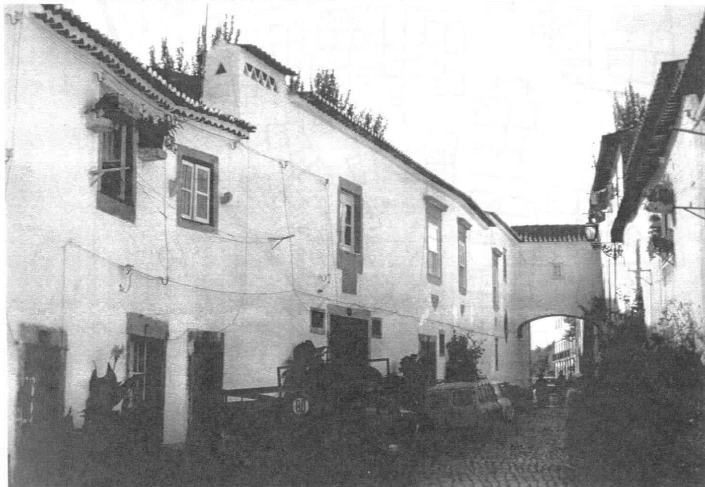
FIG.40 - Tomar: construção de alvenaria
