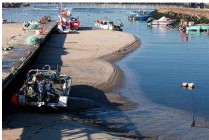
Figura 66 - Assoreamento no Porto de Vila Praia de Âncora, retirado de http://web.cm-pvarzim.pt/lanchapoveira/index.php?limitstart=72 .
