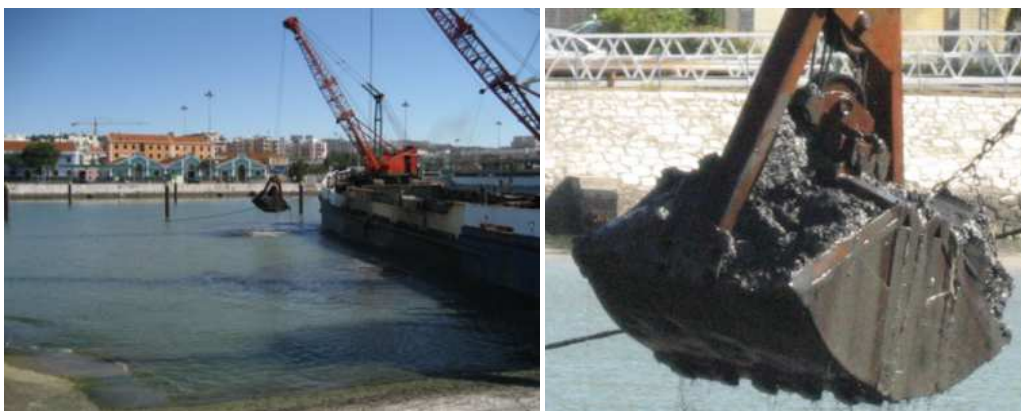
Figura 5 - À esquerda, draga de colher; à direita, colher, retiradas de Administração do Porto de Lisboa - Planos de Dragagens 2010-2015.
