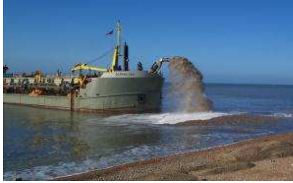
Figura 3 - Recuperação de uma praia através de uma dragagem, retirado de http://www.pevensey-bay.co.uk/recharge.html .
