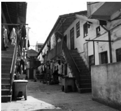
5. 6. 7. Ilhas do Porto. Estado de degradação dos núcleos habitacionais.
