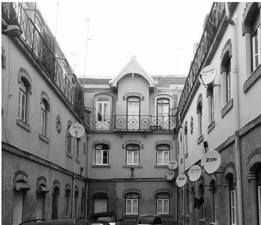
23. Fotografia da Vila Sousa onde se observa a fachada em azulejo, o letreiro em chapa esmaltada e os vãos ornamentais com as suas varandas em ferro. 24. Fotografia da Vila Luz Pereira tirada a partir do corredor central da vila. Observa-se o detalhe do tijolo que contorna os vãos, assim como as suas varandas em ferro.
