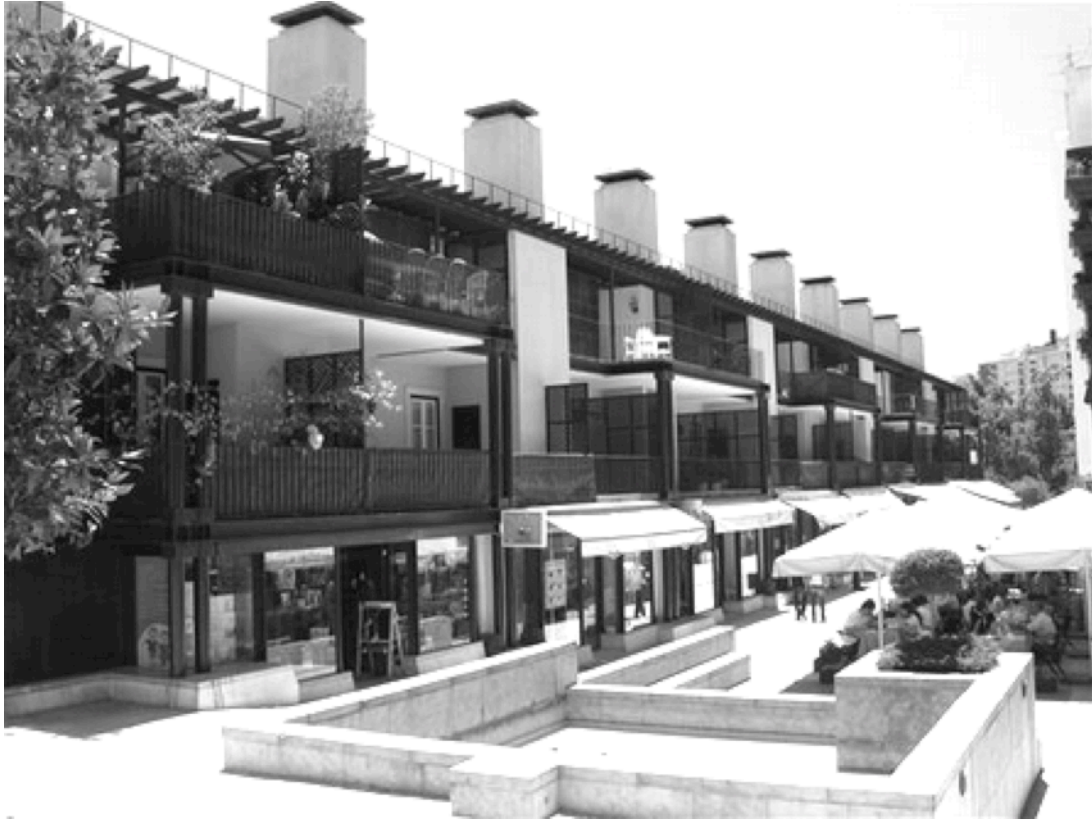
28. Pátio Bagatela – vista do espaço público exterior. Esta fachada foi alvo de grandes transformações, incluindo novas varandas, vãos e terraços e também ao nível do piso térreo os espaços de comércio e restauração que terão sido ampliados para o efeito.
