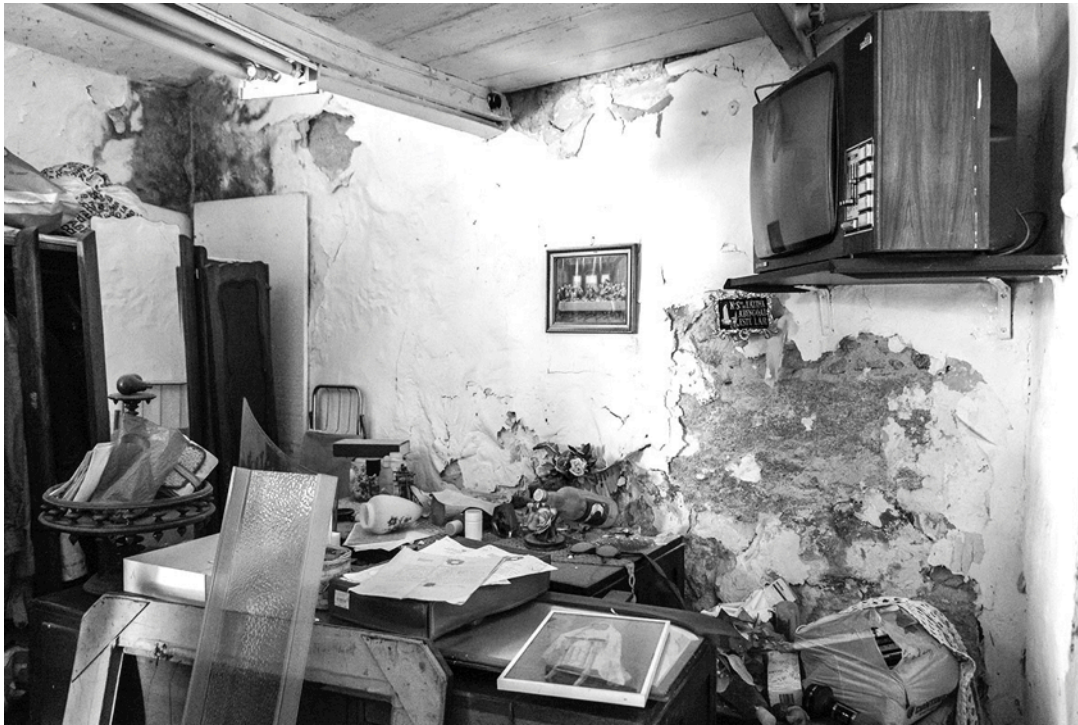
29. Ilha da Bela Vista. Vista interior de uma habitação. A fotógrafa Cristina Neves ocupou-se dos espaços em ruína na Ilha da Bela Vista. Nas fotografias em que Cristina Neves nos mostra o abandono, os objetos de quem já não mora ali, a Bela Vista parece uma ilha sem futuro.
