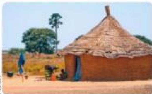
Casa de barro com telhado de palha tradicional do Senegal.
