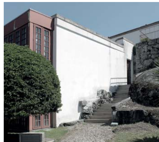
68 | Pormenor da fachada do edifício novo
