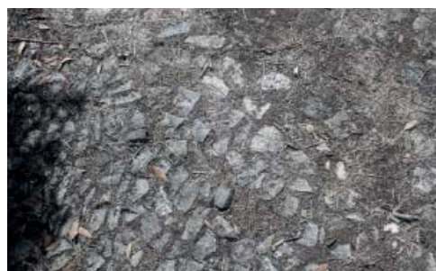
Pavimento exterior em calçada irregular de granito
