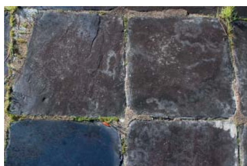
Pavimento do embasamento da casa em ardósia
