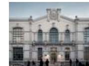
127 | Fachada do edifício da Escola de Hotelaria e Turismo de Lisboa fotografia de Fernando Guerra disponível em: http://ultimasreportagens.com/464.php
