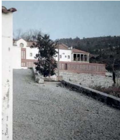
65 | Vista do edifício novo correspondente aos quartos
