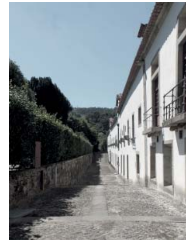
69 | Fachada posterior do mosteiro
