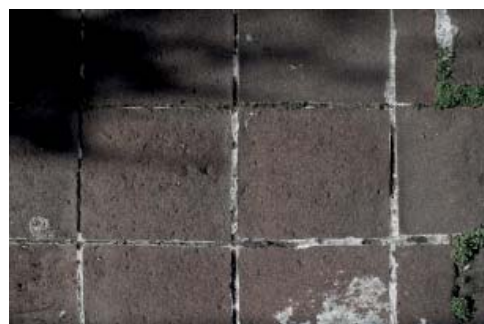
Pavimento do embasamento da casa em tijoleira
