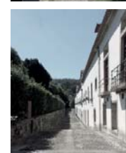
69 | Fachada posterior do mosteiro Fotografia da autora
