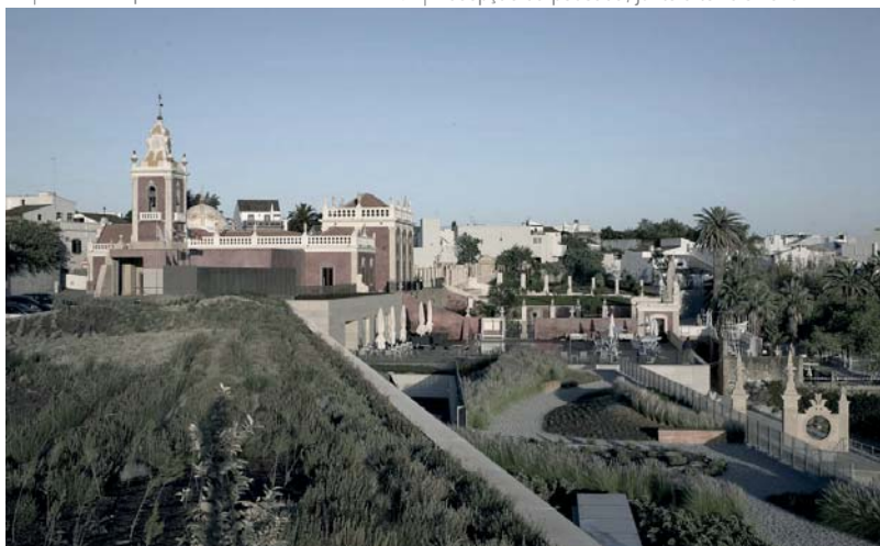
43 | Coberturas ajardinadas do edifício dos quartos
