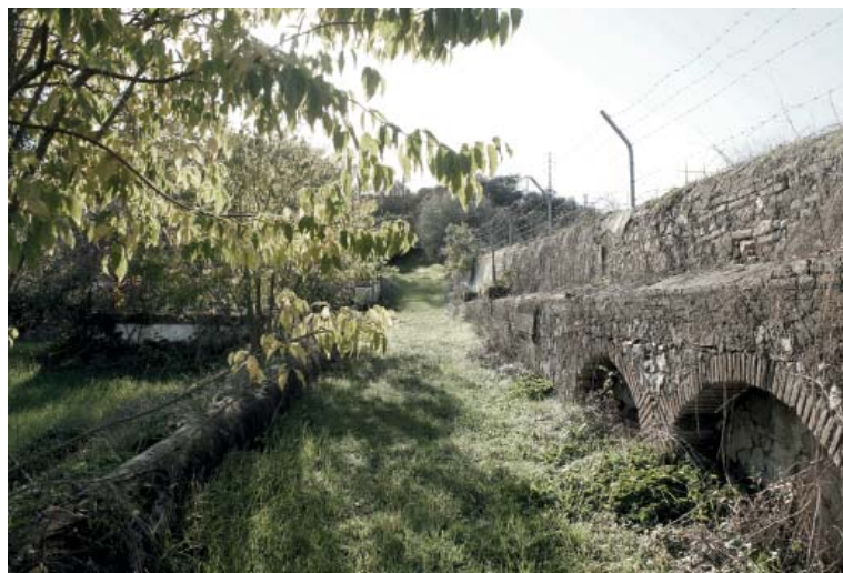
91 | Aqueduto junto ao muro que delimita a quinta
