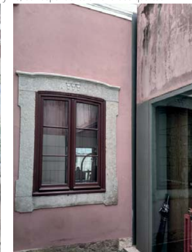
50 | Junção entre o existente e o novo
