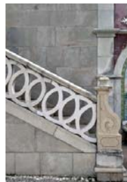
49 | Pormenor de elemento reabilitado Fotografia da autora
