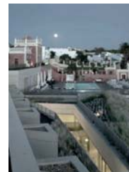
40 | Vista da cobertura para o palácio Fotografia de Duccio Malagamba disponível em: https://ducciomalagamba.com/arquitectos/goncalo-byrne/473-hotel-pousada-palacio-estoi/
