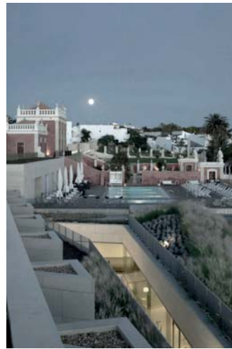
40 | Vista da cobertura para o palácio
