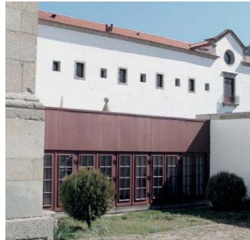
64 | Pormenor da junção entre o edifício novo e o existente
