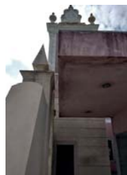
51 | Relação entre a platibanda e o pórtico existente Fotografia da autora
