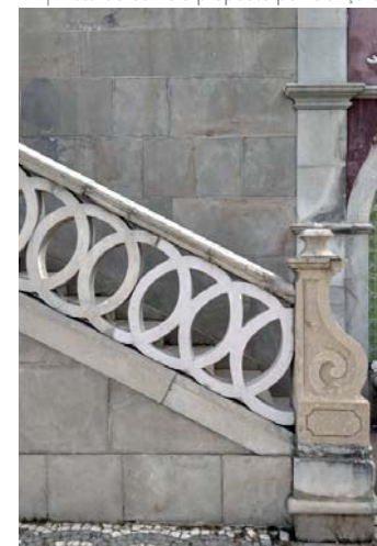
49 | Pormenor de elemento reabilitado
